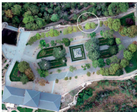
Fig. 3: Zona de la muralla norte de la Plazuela donde se encuentran los posibles capirotos. Foto: Ricardo de Cáceres Sastre y Juan Ángel Ruiz Sabina
