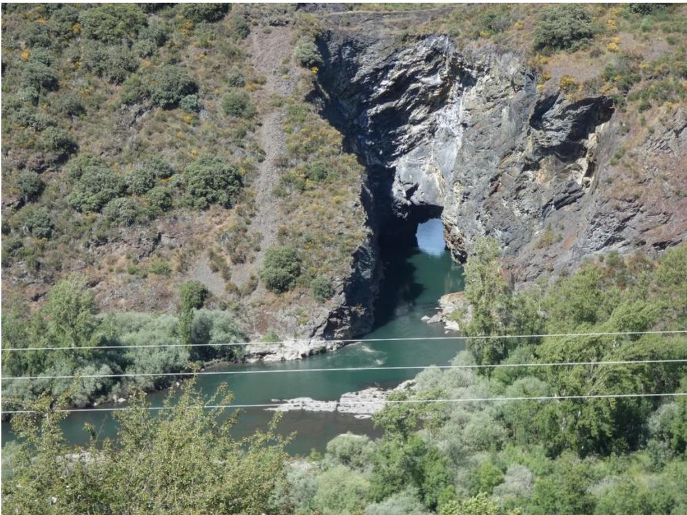
Figura 10. Túnel romano de Montefurado, perforado para buscar oro en los sedimentos del río Sil. Autor: X. García.
