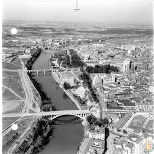
Fig. 5. Vista aérea en la que se observan los puentes de El Cubo (en primer término) y Poniente ya terminados, y los primeros trabajos de pavimentación en Huerta del Rey (a la izquierda). Archivo Municipal de Valladolid, VA 162.
