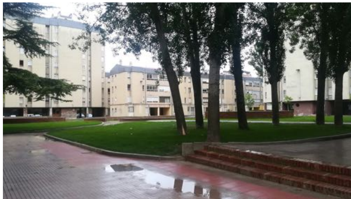
Fig. 19. Ajardinamiento a pie de inmueble en manzana de vivienda social esquina Av. Salamanca con Av. Hospital Militar (Mayo 2019, Marina Jiménez).
