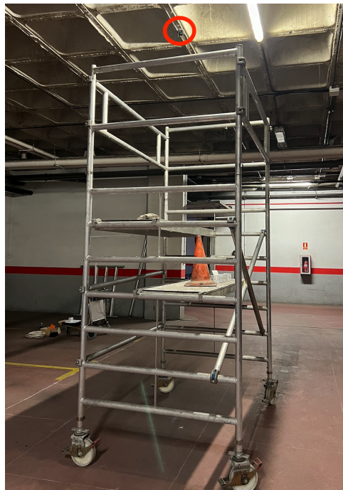
Figura 40. Andamio desplegado para poder alcanzar a situar las balizas en el techo.
