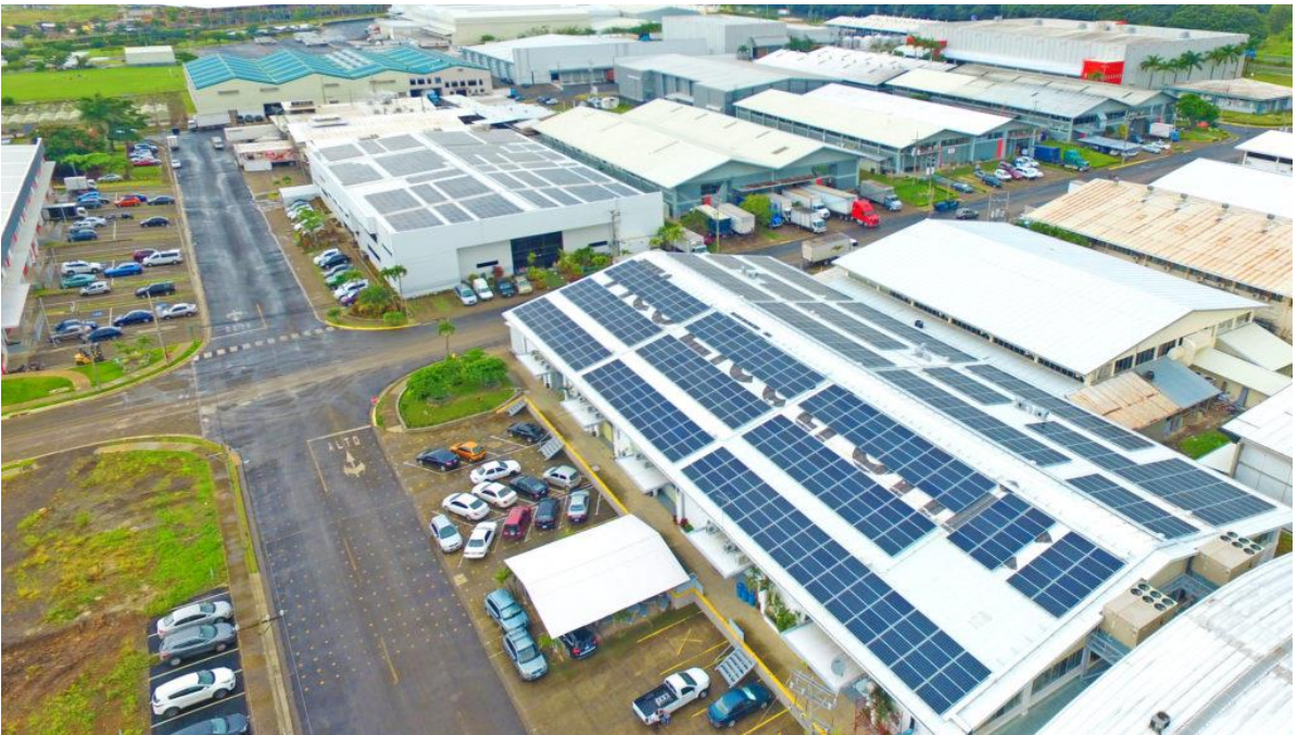
Figura 2.-Instalación Industrial sobre cubierta.
