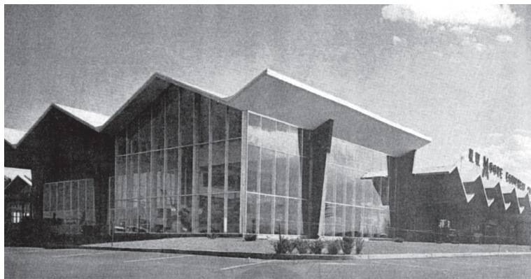
Fig. 7. Almacén y talleres de maquinaria de construcción H. W. Moore Equipment Co. en Denver de M. Kechum. Informes de la Construcción , n. 529, p. 30.
