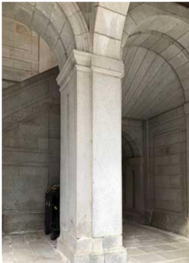
Figura 16. Detalle de uno de los pilares dobles de la escalera principal del alcázar.
