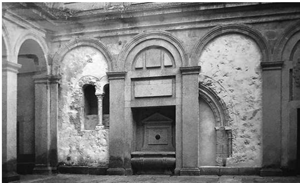
Figura 2. Restos de la portada y una ventana del antiguo cuarto del Mediodía a la vista durante unas obras José Miguel Merino de Cáceres. La fábrica del Alcázar de Segovia , Patronato del Alcázar de Segovia, 1991, figura 7.
