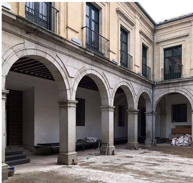
Figura 20. Aspecto de las columnas monolíticas del palacio episcopal de Segovia. Plaza de San Esteban.
