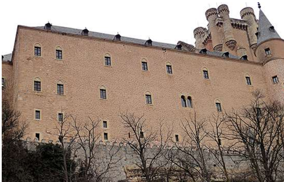
Figura 4. Cuarto de Mediodía del primer patio. Vista general.
