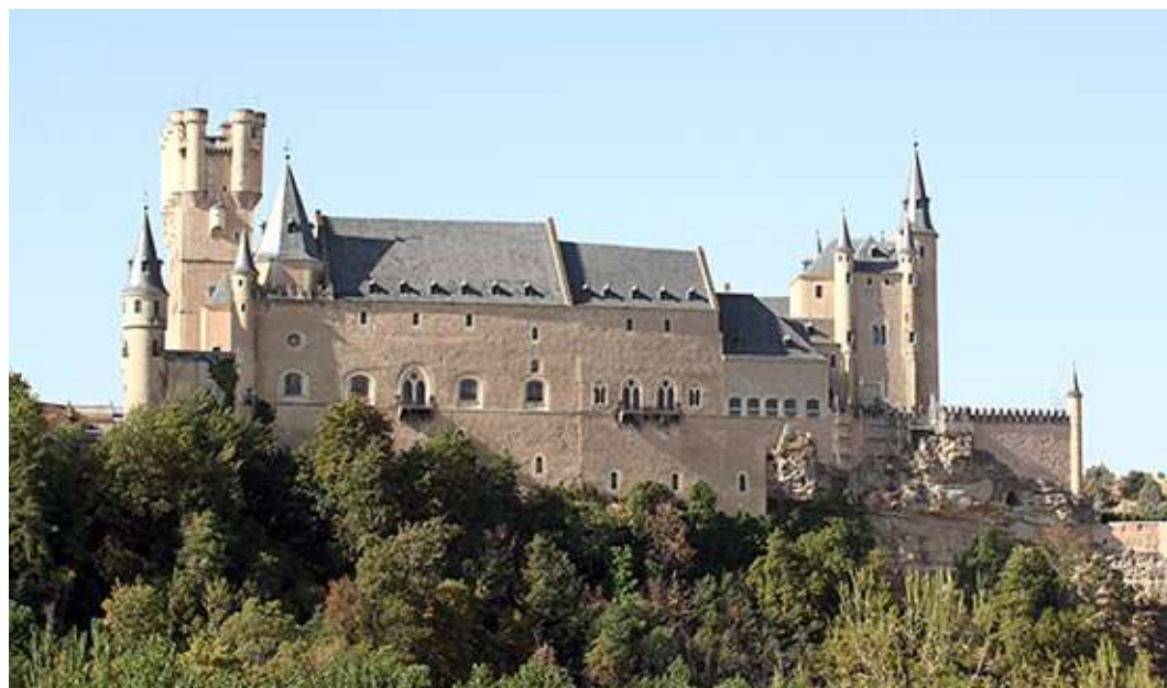
Figura 14. Cuarto del Cierzo. Vista general.
