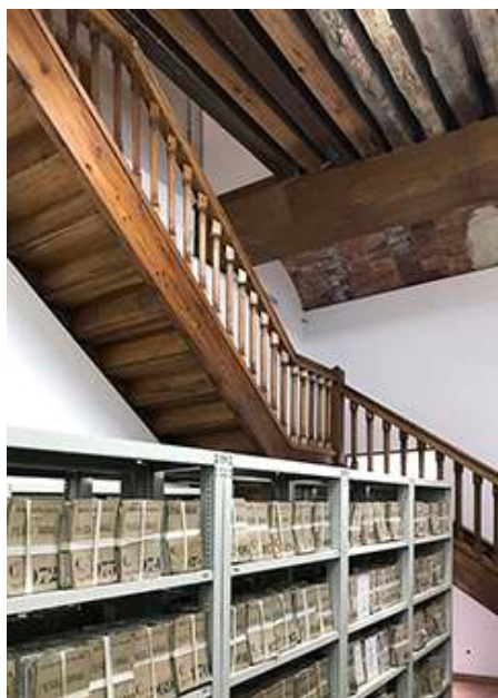
Figura 6. Escalera interior con resto del cañón.
