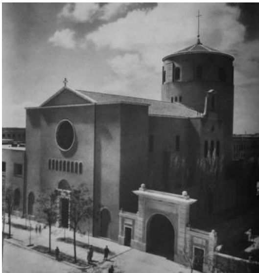
Fig. 2 y 3. Fisac. Iglesia del Espíritu Santo (Madrid) exterior: sobre la portada rosetón, ábside cubierto con cúpula sobre elevado mediante tambor horadado con diez vanos. A la derecha: vista interior (Fundación Fisac), 1942.
