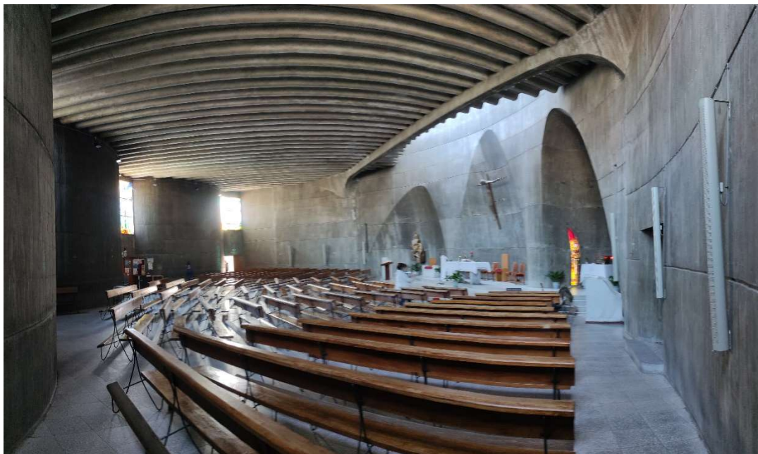
Fig. 43. Fisac. Santa Ana , (Moratalaz), vista interior (téc.) hormigón visto, planta en asamblea, ábsides de la cabecera, iluminación mediante lucernario y vanos sobre los accesos (Madrid), 1965. Fotografía de autora.
