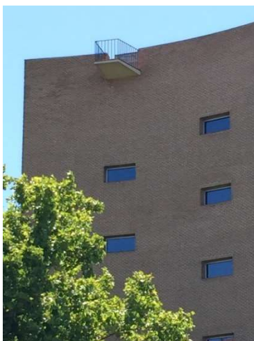
Fig. 12. Fisac, Chaflán : balcón voladizo y ventanas asimétricas, Centro de Investigaciones Científicas (Madrid), 1951.
