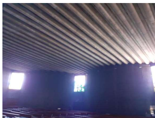
Fig. 43. Fisac. Santa Ana , (Moratalaz), vista interior (téc.) hormigón visto, planta en asamblea, ábsides de la cabecera, iluminación mediante lucernario y vanos sobre los accesos (Madrid), 1965. Fotografía de autora.
