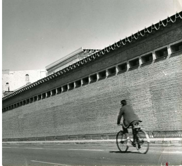
Figs. 16 y 17. Fisac. Instituto Núñez de Arce (Valladolid), vistas del patio-jardín, vigas hueso durante su construcción y fachada en Paseo Isabel la Católica. Derecha: detalle del muro, hormigón, ventanas Citroën y vigas hueso en la cubierta, 1961.
