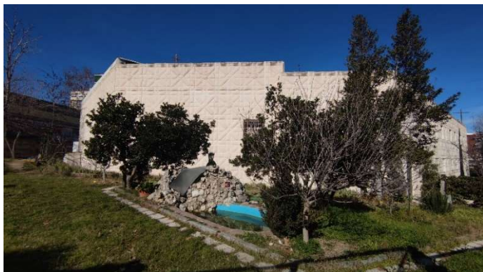
Figs. 53 y 54: Fisac. Nuestra Señora de Altamira , vista exterior del jardín y acceso al templo (téc.) hormigón fraguado en encofrados plásticos con decoración que evoca los alicatados de la Alhambra de Granada. La espadaña metálica y la Cruz se sitúan en un espacio cúbico adosado a los pies del templo que simula una torre de la misma altura que el templo (Madrid), 1983.
