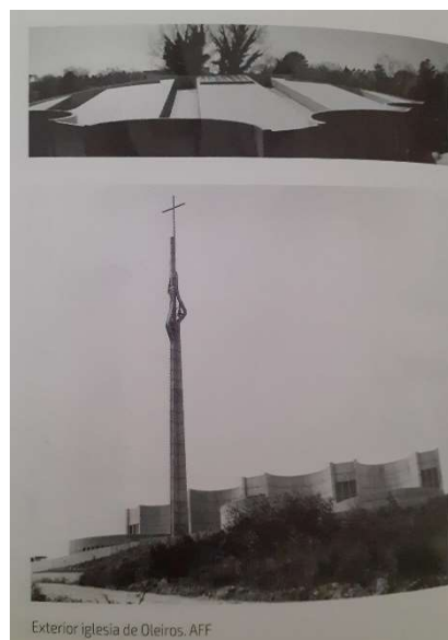
Fig. 51. Fisac. Santa Cruz de Oleiros , vista exterior, muro de los pies realizado a base de cóncavos y convexos. Arriba detalle de la cubierta. Archivo de la Fundación Fisac. (Ciudad Real)
