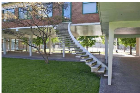
Figs. 71. Javier Lahuerta. Escalera en voladizo (hormigón). Fig. 72 Fisac. Atrio-jardín , Teologado San Pedro Mártir (Madrid), 1955.
