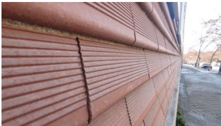
Fig. 10. Fisac. Ladrillo hueco de cerramiento , Centro de Investigaciones Científicas (Madrid), 1951. Fotografía de autora.
