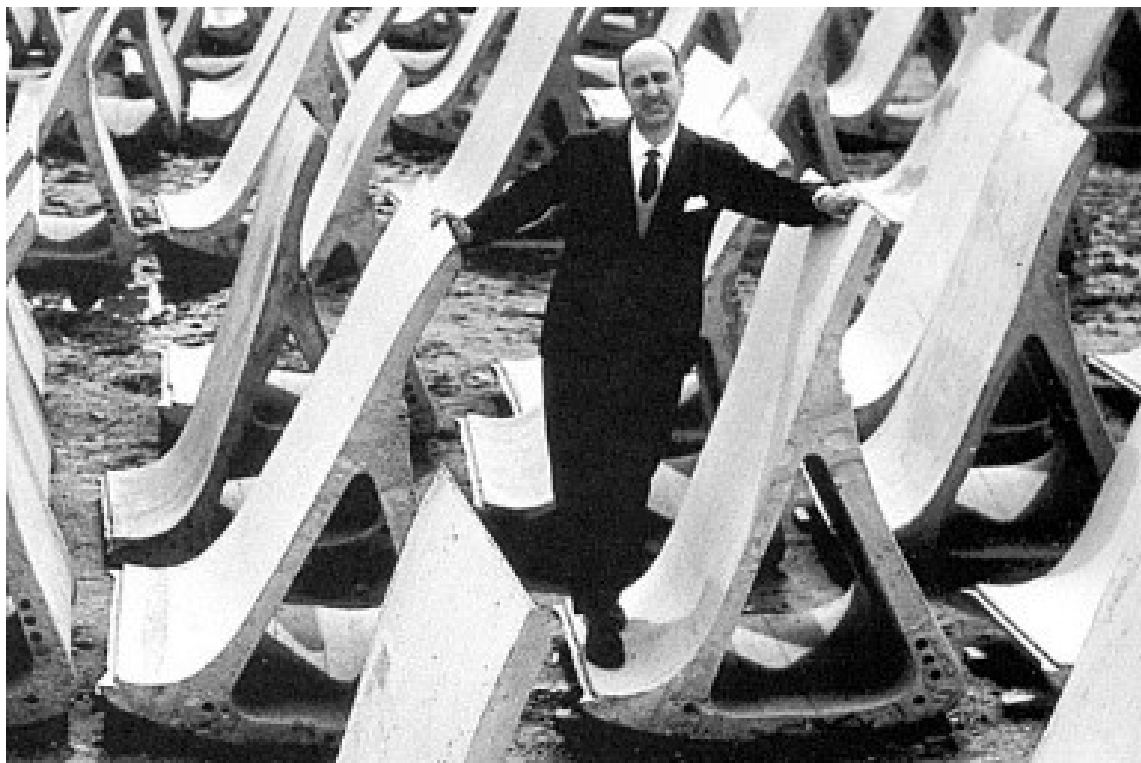
Fig. 13. Miguel Fisac Serna, vigas huesos inventadas para el cerramiento de la nave de modelos en el Centro de Estudios Hidrográficos, (Madrid) 1962.
