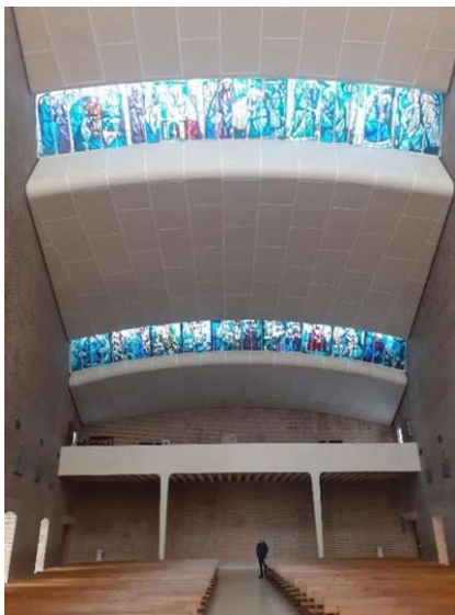
Fig. 25. Fisac. N.ª. S.ª. del Rosario (Valladolid) interior de la nave, coro a los pies soportes de hormigón. Iluminación de la nave mediante vidrieras, (fotografía de autora).
