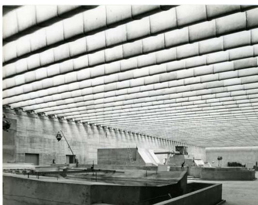
Figs. 22 y 23 Fisac. Centro de Estudios Hidrográficos, nave de modelos y marquesina de acceso con cubiertas de vigas hueso (Madrid), 1960.
