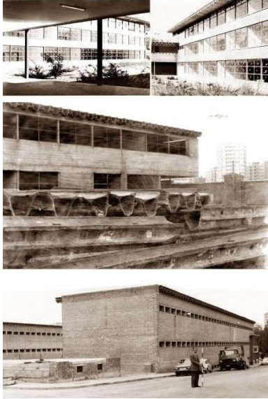
Figs. 16 y 17. Fisac. Instituto Núñez de Arce (Valladolid), vistas del patio-jardín, vigas hueso durante su construcción y fachada en Paseo Isabel la Católica. Derecha: detalle del muro, hormigón, ventanas Citroën y vigas hueso en la cubierta, 1961.
