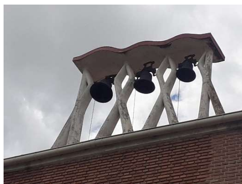
Fig. 28: Fisac. Espadaña, N.ª. S.ª. del Rosario (Valladolid). Material vigas de hormigón, descripción: soporte, campana, campana al vuelo y soporte. Fotografía de autora.
