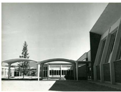
Fig. 13 Fisac. Ciudad Universitaria , pórtico (Madrid), 1953.
