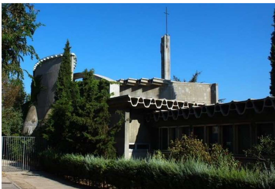
Fig. 97. Fisac. Santa Ana de Moratalaz , vista exterior, cabecera y campanario, hormigón armado. Cubierta: vigas hueso (téc.) hormigón postesado (Madrid), 1965.
