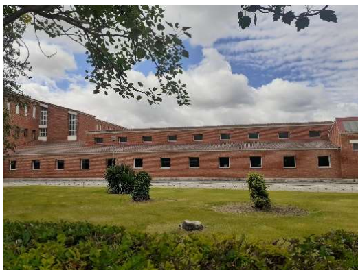
Fig. 27: Fisac. Colegio Arcas Reales (Valladolid), vista de un pabellón de aulas, elevación por encima del corredor de acceso permitiendo horadar ventanas a ambos lados. (fotografía de autora). 1952.
