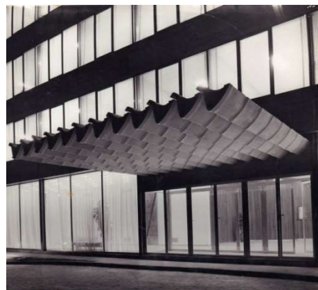
Figs. 22 y 23 Fisac. Centro de Estudios Hidrográficos, nave de modelos y marquesina de acceso con cubiertas de vigas hueso (Madrid), 1960.
