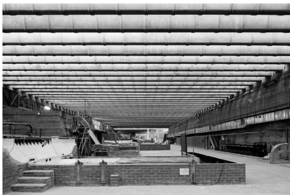
Figs. 14 y 15. Fisac: Nave de modelos (Centro de Estudios Hidrográficos, Madrid), vista interior: de la nave (22x80 metros) cubierta con vigas hueso sin soportes (hormigón pretensado).
