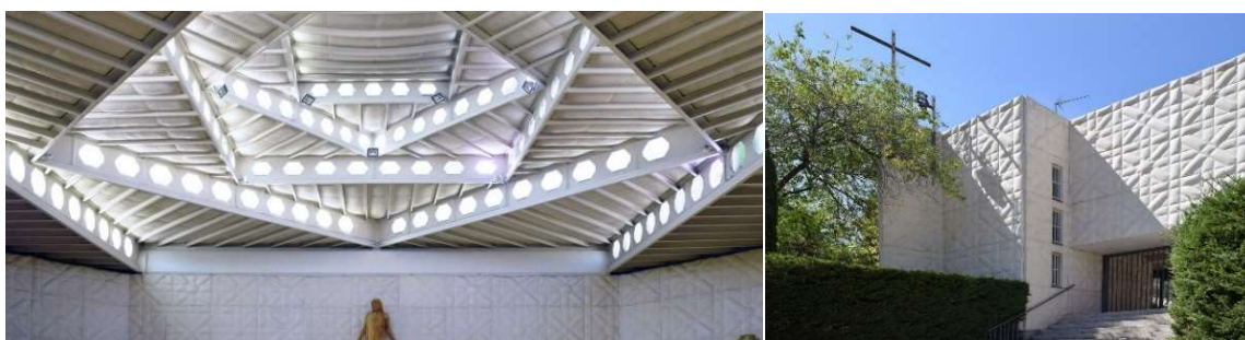
Fig. 106 y 107. Fisac. N.ª. S.ª. de Altamira , cubierta interior (téc.) vigas Vierendeel . Vista exterior, hormigón (téc.) fraguado en encofrados plásticos formando dibujos geométricos (Madrid), 1983.
