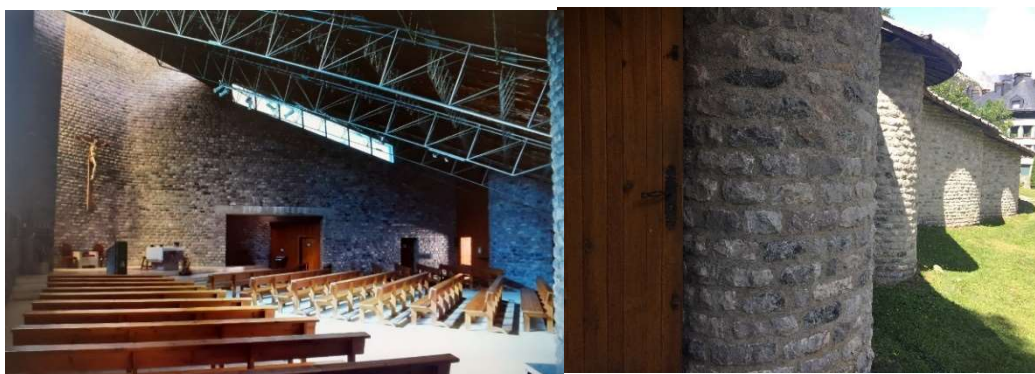
Figs. 42 y 43. Fisac. Nuestra Señora del Pilar (Canfranc), vista interior (téc.) presbiterio sobreelevado para introducir lucernario, muros de sillarejo visto, cubierta con cerchas metálicas vistas. Vista exterior, muro sinuoso dispersivo del sonido, 1964-1969.
