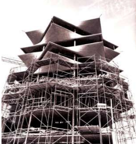
Figs. 24 y 25 Fisac. Pagoda Laboratorios Jorba (téc.) cerramiento de arriba hacia abajo (Madrid), 1965.
