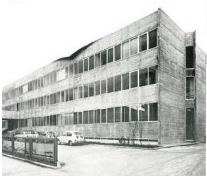
Fig. 18: Fisac. Centro de Información y Documentación , vista exterior: material: hormigón y vidrio (téc.) hormigón fraguado en encofrados de madera dejando huella de las tablas. En la cornisa superior aparece una incisión conocida como el labio , elemento muy expresivo, que rompe la monotonía de la fachada, (Madrid) 1961-67.
