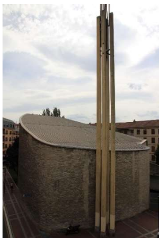
Figs. 79 y 80. Fisac. La Coronación de N.ª. S.ª. exterior , (téc.) mampostería. Campanario, hormigón y acero (Vitoria), 1958.
