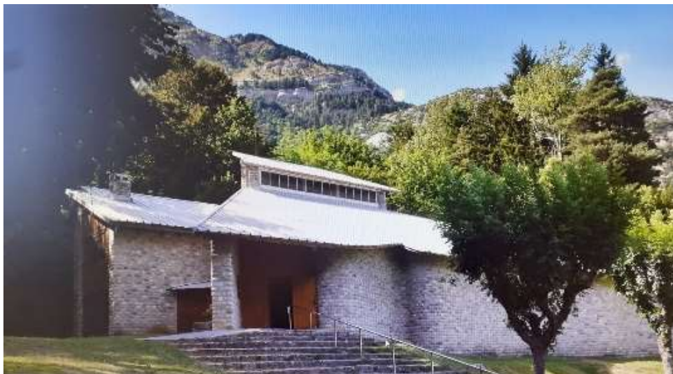
Fig. 42 Fisac. Nuestra Señora del Pilar , Canfranc (Huesca), vista exterior (téc.) sillarejo de piedra de la zona, gran inclinación de la cubierta para evitar acumulaciones de nieve. Iglesia organicista, los materiales y las formas se adaptan al terreno. 1964-1969.
