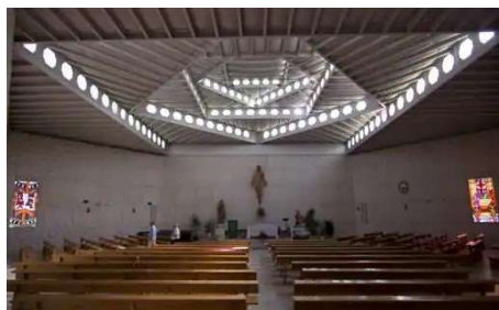
Figs. 56 y 57: Fisac. N.ª. S.ª. del Pilar (Madrid) vista interior, (téc.) hormigón visto, cubierta a base de vigas Vierendeel que permiten gran iluminación del templo. Imágenes del altar Cristo Resucitado y Virgen con Niño (téc.) bulto redondo.
