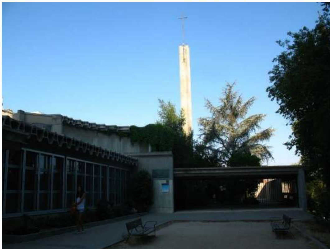
Fig. 47: Fisac. Conjunto Parroquial de Santa Ana (Moratalaz) vista exterior de las dependencias Cubiertas Vigas Huesos , al fondo Campanario de hormigón rematado con la Cruz. (Madrid), 1965. Fotografía de autora.
