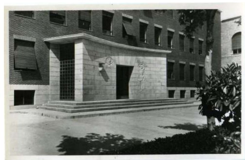
Fig. 8 Fisac. Instituto de Óptica Daza de Valdés (Madrid), 1948.
