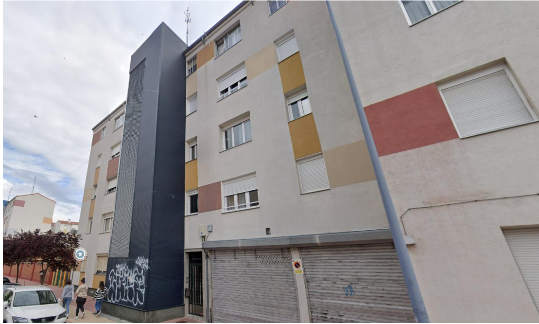
Figura 19. Ejemplo de la rehabilitación y de la instalación de ascensores en la Calle Pinzones, 4. Fuente: Google Street View (abril de 2023).
