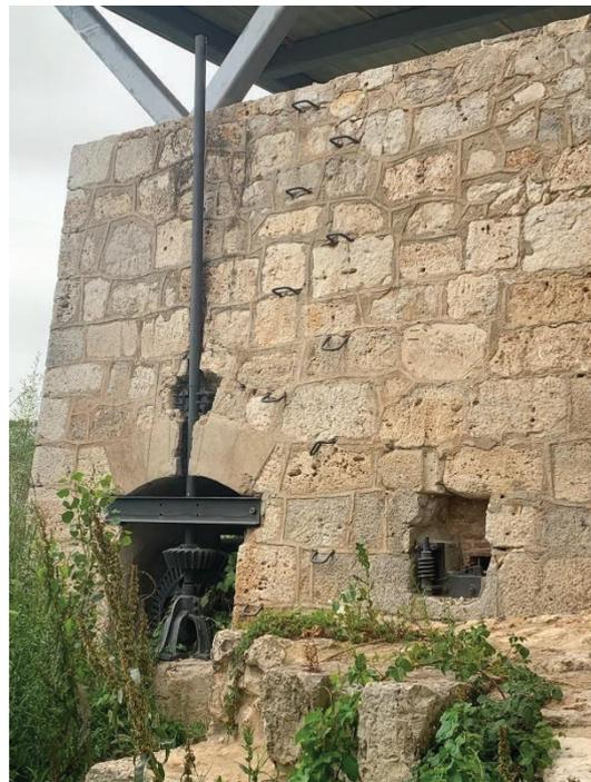
Figura 53: Arriba a la izq., ruedas de palas encajadas en el arco del puente; Figura 54: Arriba a la der., detalle del cubo de piedra y de los engranajes de la aceña.
