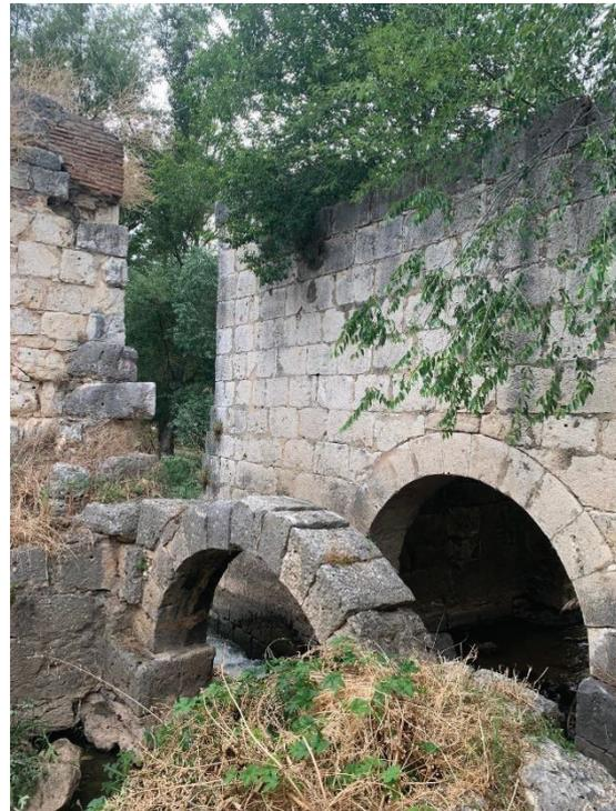
Figura 59: Arriba a la izq., interior de uno de los cuerpos de la aceña; Figura 60: Arriba a la der., detalle de los arcos de piedra de los cárcavos.
