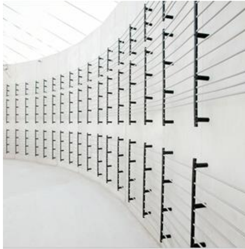
Imagen 5. Intercambiadores de calor de un digestor
