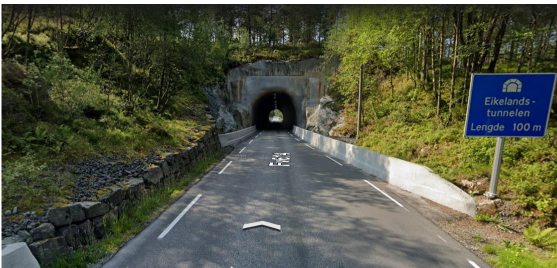
Figura 14. Túnel de Eikeland
