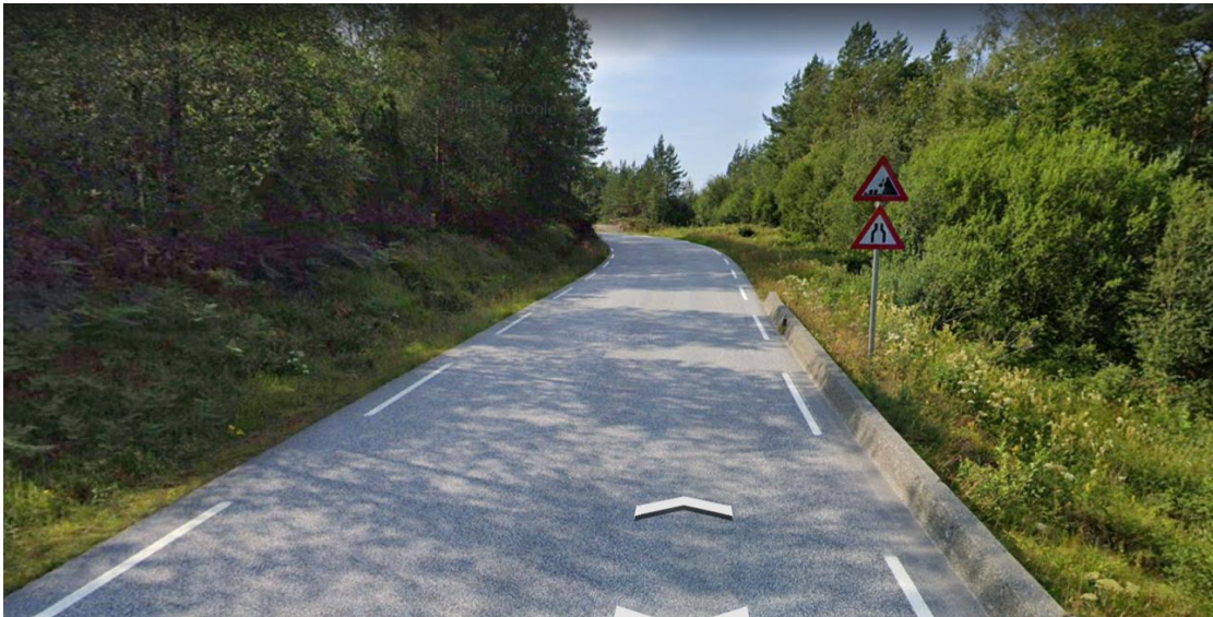
Figura 13. Márgenes de la carretera hasta el site
