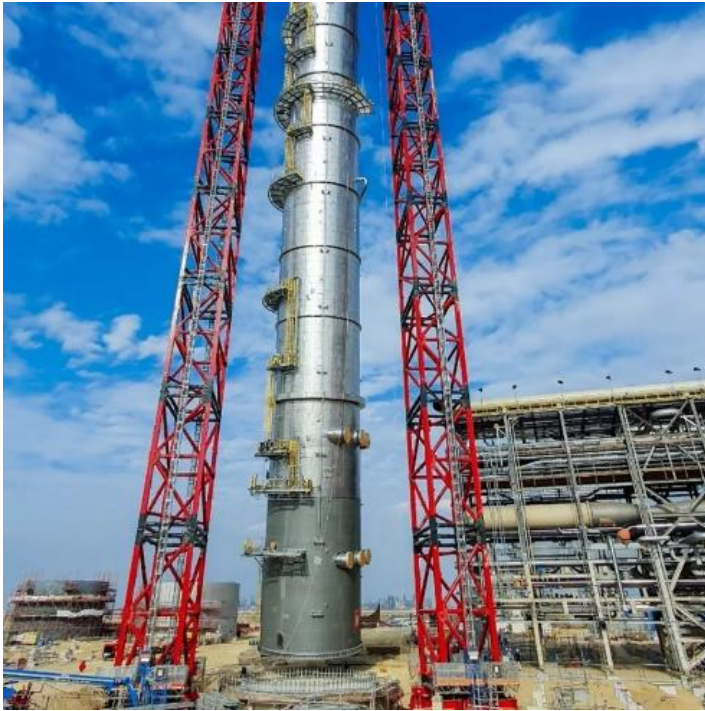
Figura 1. Montaje de equipo crítico
