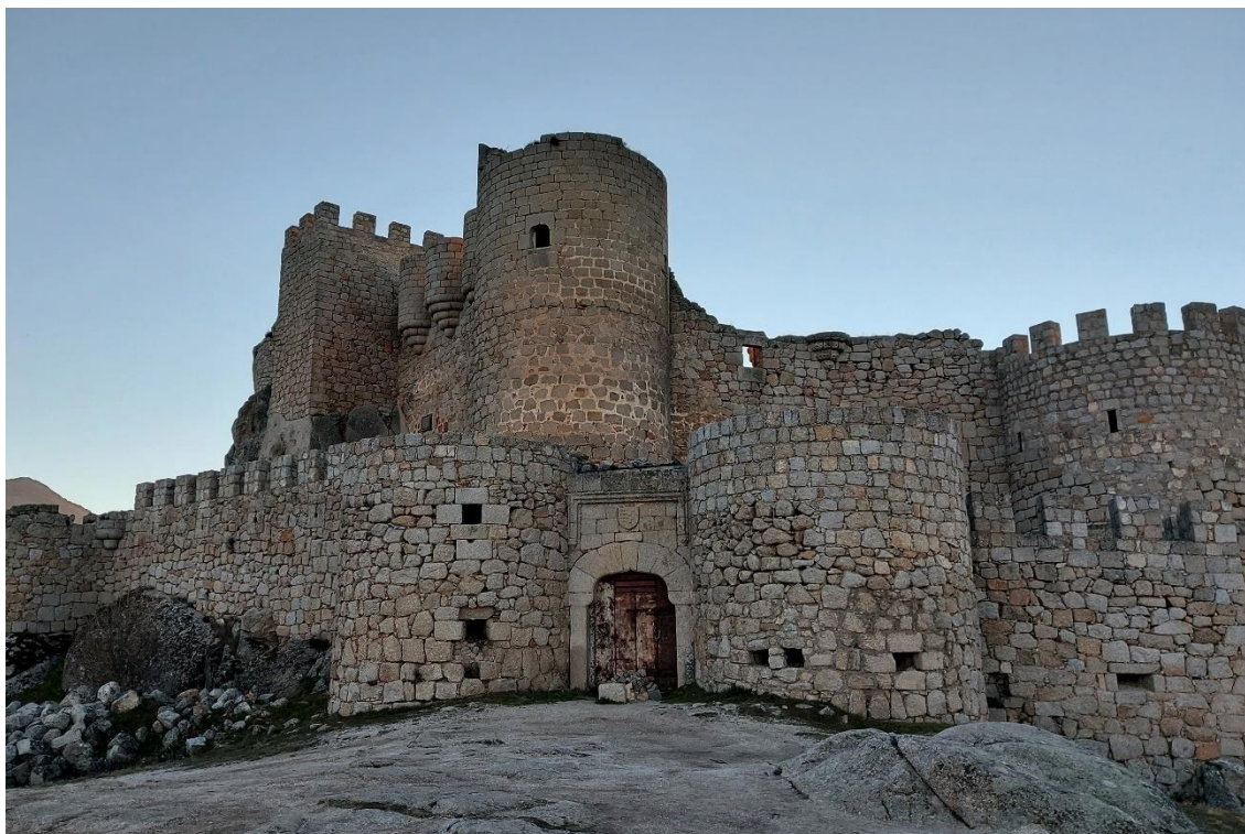
Figura 65. Fachada principal del Castillo de Manqueospese
