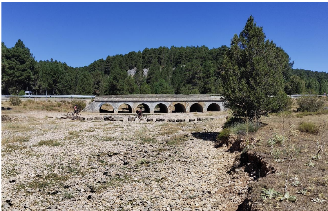
Figura 98 . Puente de los Siete Ojos, con el Río Lobos completamente seco (fecha 15/08/2024)
