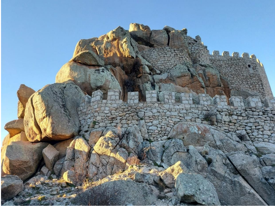
Figura 66. Lateral del castillo de Manqueopese, integrado en los grandes bloques de granito
