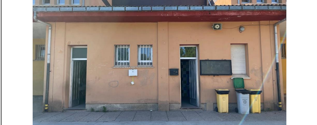
Zona de baños de abajo
