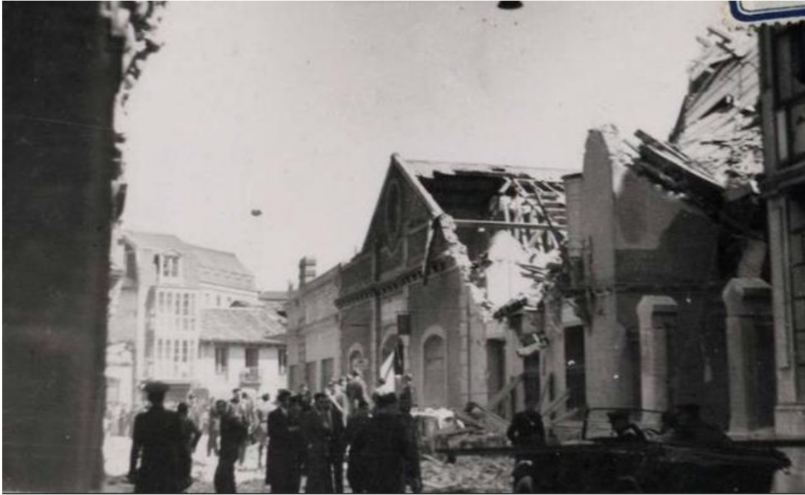
Destrozos causados en Valladolid en las cercanías de la calle Miguel Íscar
