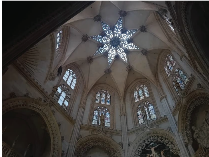
Fig. 36. Altura de la capilla del Condestable en la catedral de Burgos. Fuente: elaboración propia.
