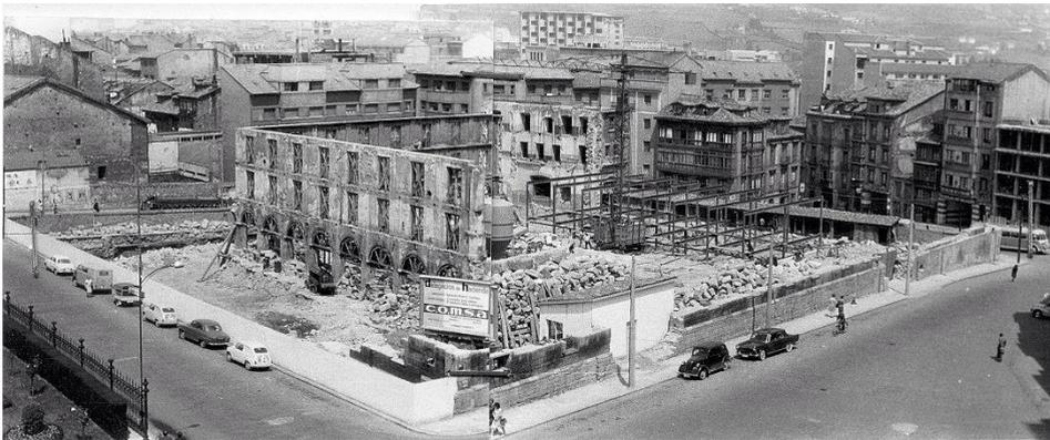
Fig. 3. Estado del convento en 1965, tras la demolición de las partes suprimidas (se aprecia el inicio de los trabajos de montaje de la estructura metálica del edificio de Castelao).
