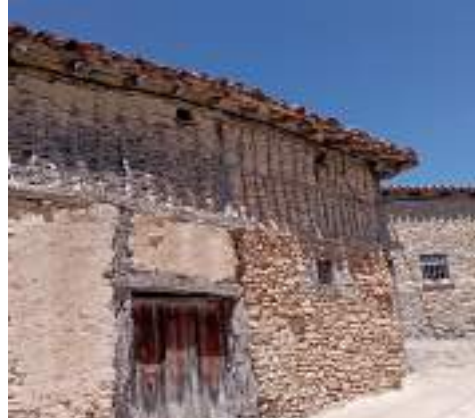
Figura 41. Aspecto de una casa típica de La Cuenca, en cuya fachada pueden verse diferentes elementos con madera de sabina (setos, marcos, canes,...)
