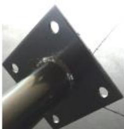
Imagen 14: anclaje para que el poste agarre en el hormigón
