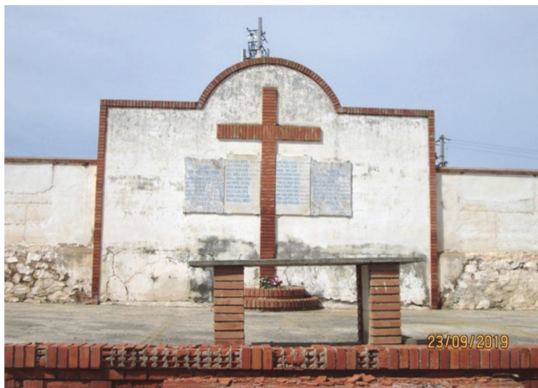
Ilustración 38: Monumento a los caídos en Santa Eulalia del Campo, Teruel. Fuente: Archivo fotográfico personal (23-9-2019).
