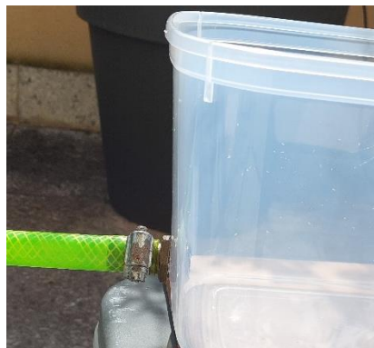
Figura 3-23 Entrada de agua al depósito
