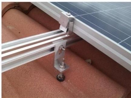
*Figura 4. Soportes para módulos fotovoltaicos*
