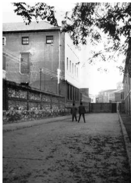
291-292. Cine Luises- Kostkas . Valladolid 1941. Fotos del exterior con su acceso y durante una sesión cinematográfica.
