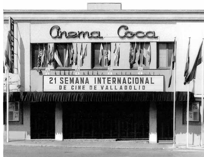
414. Isaías Paredes y Ángel Ríos: Reforma Cinema Coca . Valladolid 1961. Alzado fotográfico en 1977. D. Villalobos 2020.
