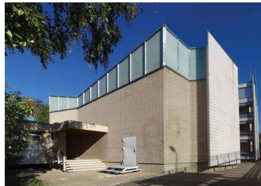
265-266. Isaías Paredes y Ángel Ríos: Salón-Cine Casa Cuna . Valladolid 1968. Fotos del acceso y exterior de la sala cine. D. Villalobos 2015 y 2020.
