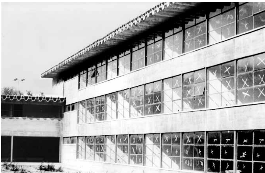
Fig. 11 Instituto Núñez de Arce en construcción. Bloque de aulas.
