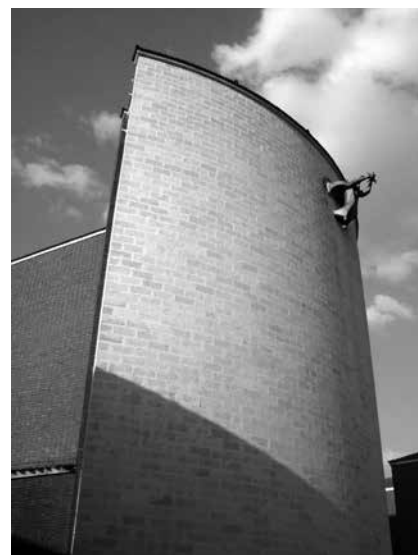
Fig. 1 Miguel Fisac: Colegio Apostólico de los P.P. Dominicos . Valladolid (1951-1957). Foto durante la obra hacia 1954.
