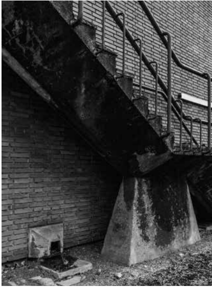
Fig. 8 Nave de Tableros Aislantes . Fotografía de la escalera exterior en alzado norte.
