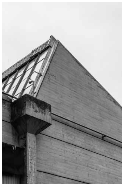
Fig. 5 Nave de Tableros Especiales . Fotografía de los dientes de la cubierta y detalle del canalón.
