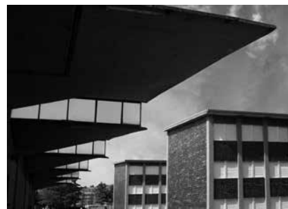
Fig. 1 Luis Feduchi: Escuelas de Cristo Rey . Valladolid (1963-1968). Vista general del complejo educativo desde la marquesina de los talleres.
