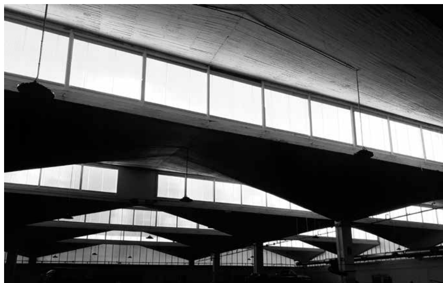
Fig. 12 Escuelas de Cristo Rey . Valladolid (1963-1968). Foto del interior de las ventanas de las naves de talleres.
