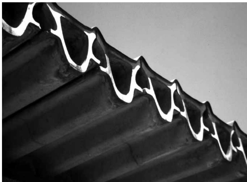
Fig. 7 Miguel Fisac: Colegio de la Asunción de Cuestas Blancas . Madrid, 1965. Detalle de huesos de cubierta.
