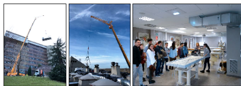
Fig 1. Obras Sistema de ventilación de formaldehído de la Fac. de Medicina.
