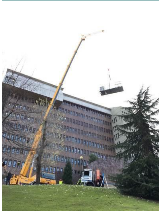
Fig 7. Instalación del climatizador de la sala de disecciones de la Facultad de Medicina.
