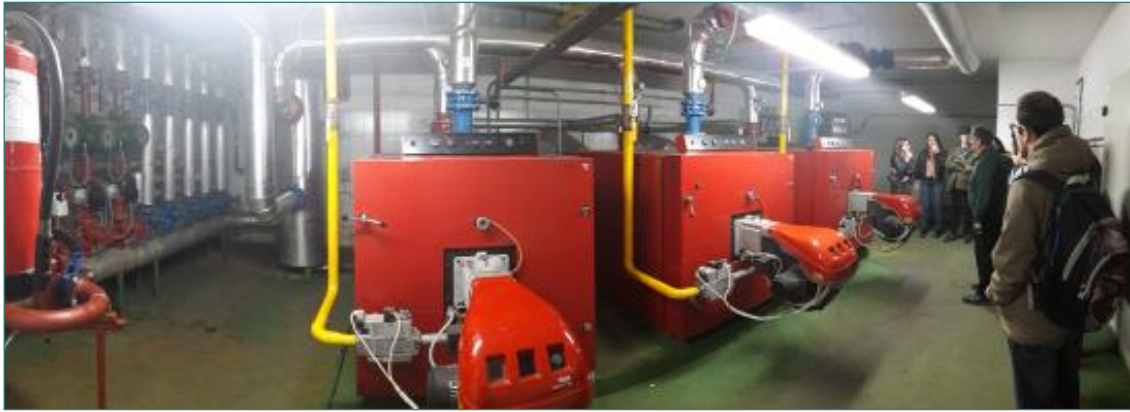
Fig 2. Visita a la sala de calderas de la Facultad de Químicas.
