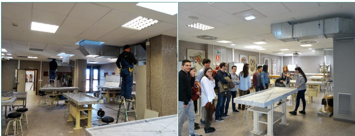
Fig 7. Instalación del climatizador de la sala de disecciones de la Facultad de Medicina.
