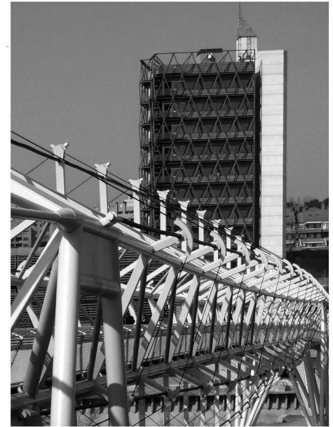
18. Pasarela sobre el río Pisuerga y Torre del Museo de la Ciencia.
