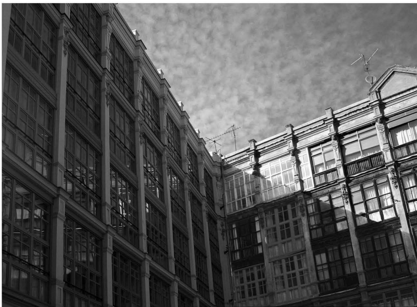
13. Casa "Mantilla". Fachada de patio principal a la calle Mantilla.
