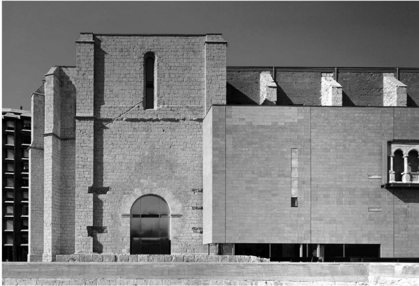
12. Archivo Municipal "San Agustín". Ábside y detalle del cerramiento Sur.
