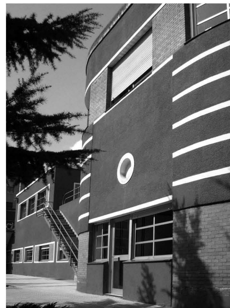
1. Costantino Candiera. Casa "del Barco". Valladolid, 1935-36. Detalle de ala Este,
