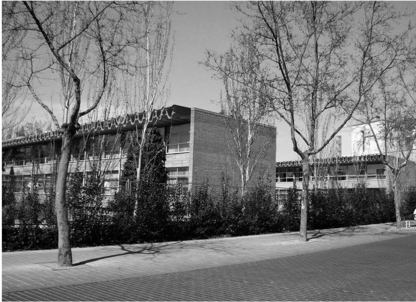
10. Instituto Núñez de Arce. Bloques de aulas, reconstrucción de su estado inicial (D. Villalobos).
