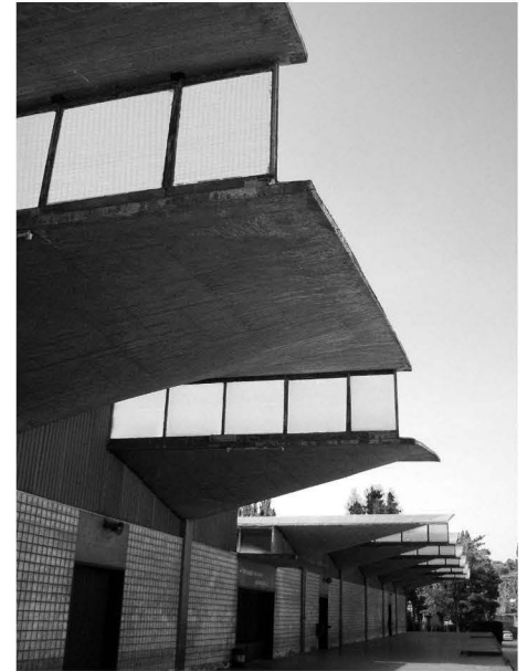
1. Luis M. a Martínez Feduchi . Colegio de Cristo Rey. Valladolid, 1965. Nave de Talleres.
