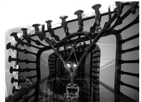
18. Casa "Mantilla". Balaustrada y caja del antiguo ascensor del portal nº 1 de la Acera de Recoletos.
