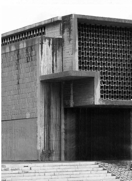
9. Mercado Central de Abastos. Diferentes formas de utilización del hormigón.
