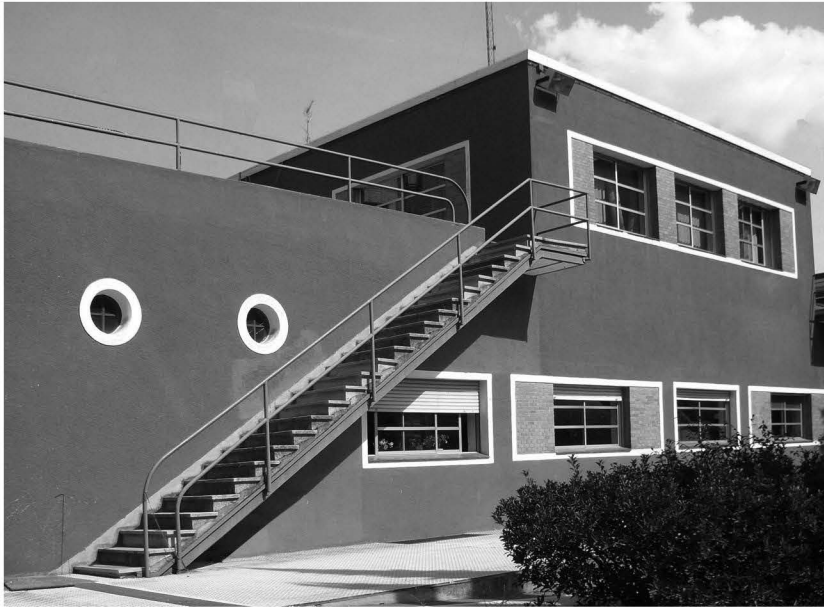
9. Casa "del Barco". Detalle de escalera y ala Este.
