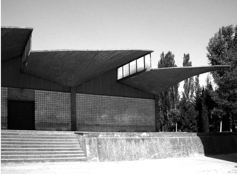
11. Nave de Talleres del Colegio de Cristo Rey. Escalera de acceso a la plataforma.
