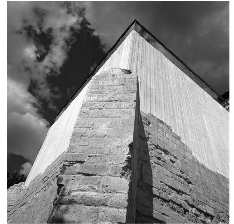
7. Museo "Patio Herreriano". Exterior de la Capilla de los condes de Fuensaldaña.
