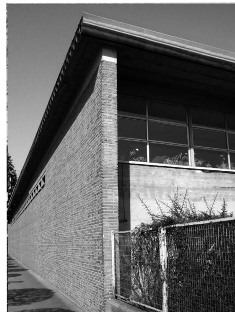
1. Miguel Fisac . Instituto Núñez de Arce. Valladolid, 1961. Fachada del Paseo de Isabel la Católica, reconstrucción de su estado inicial (D. Villalobos).
