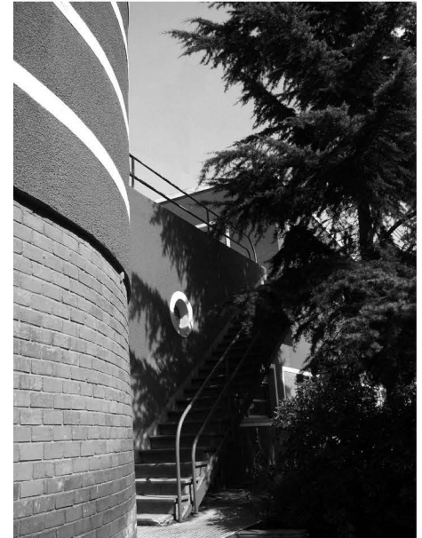
12. Casa "del Barco". Detalle de materiales de fachada.
