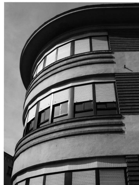
1. Joaquín Muro Antón. Colegio “San Fernando”. Valladolid, 1932-50. Detalle de rotonda.
