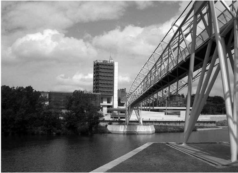
16. Rafael Moneo y Enrique de Teresa. Pasarela sobre el río Pisuerga. Valladolid, 2004.
