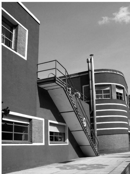
7. Casa "del Barco". Acceso a cubierta.
