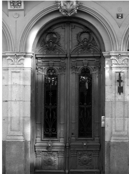
16. Casa "Mantilla". Puerta del portal nº 2 de la calle Miguel Íscar.
