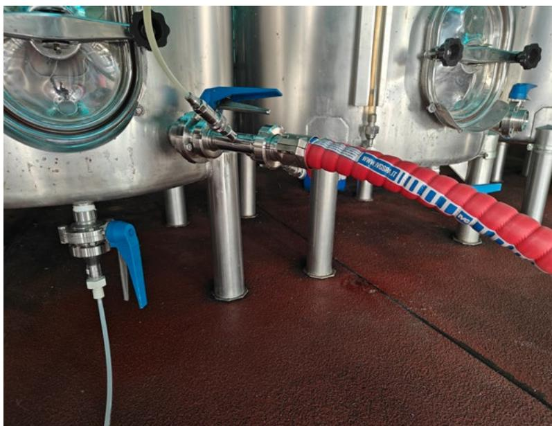
Fig. 13.7.- Ligação recomendada para a inertização de mangueiras e reservatórios com duas válvulas
