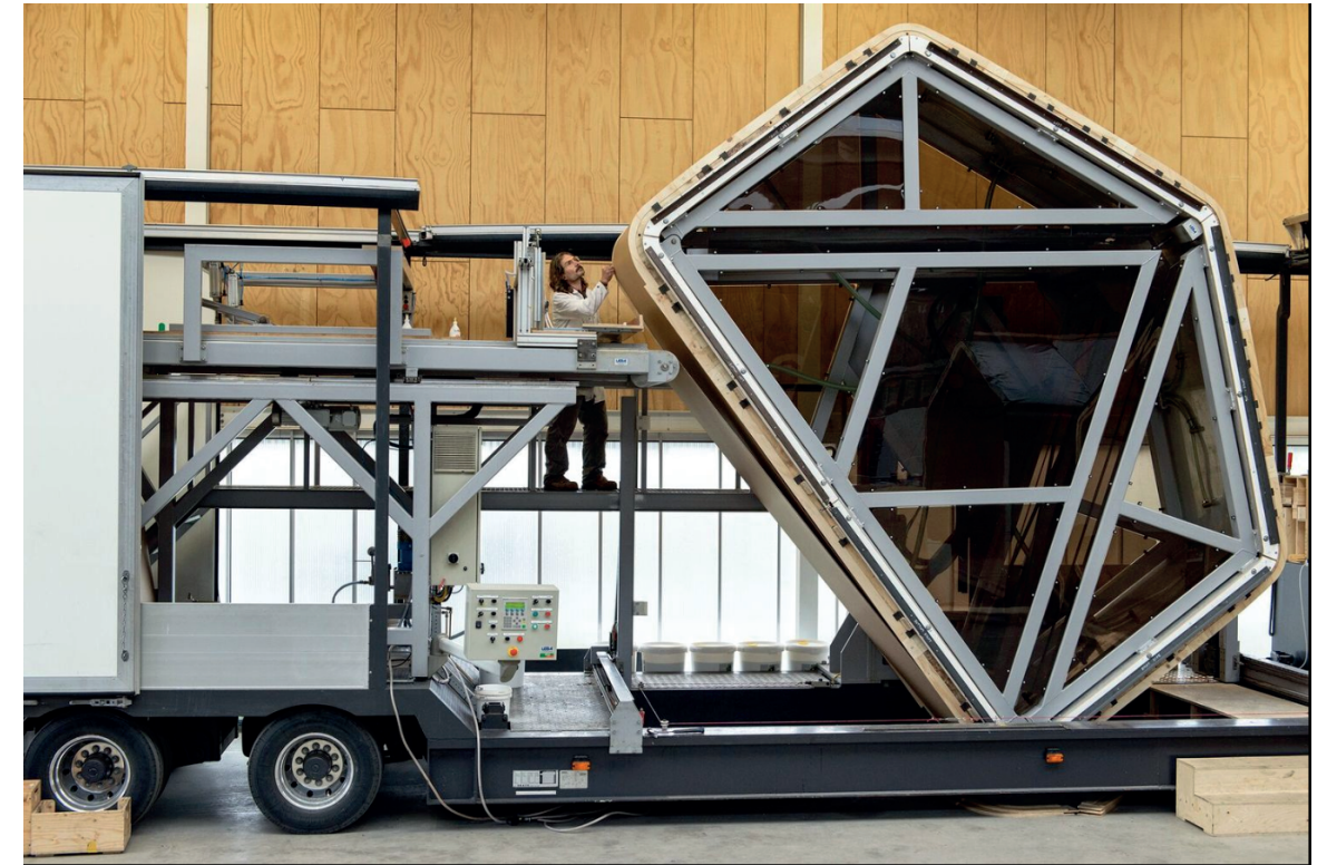
FIG. 33- Proceso constructivo de la Wikkellhouse FUENTE - Fiction factory
