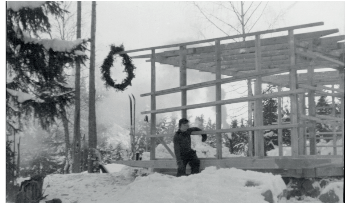
FIG. 24- la caja en construcción, Ralph Erskine. FUENTE - CICARQ
