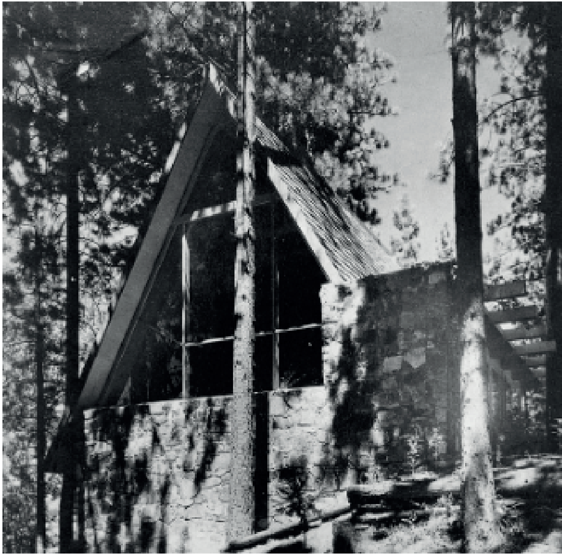
FIG. 42 - Exterior de la casa Bennati
