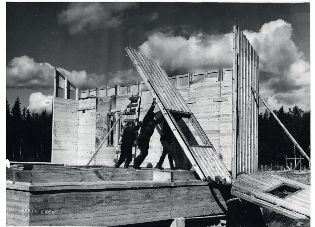
FIG. 05 - Construcción de una vivienda prefabricada FUENTE - Archdaily
