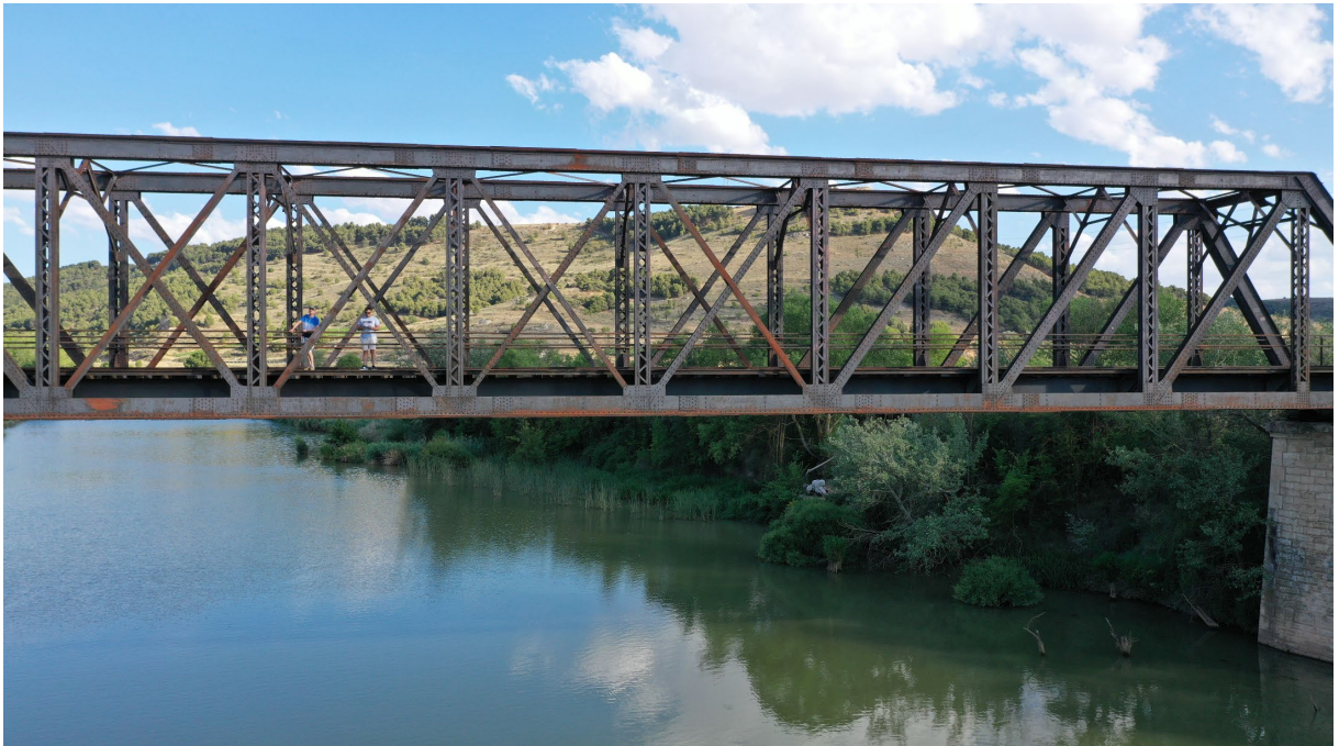
Vista lateral del puente de El Carrascal y el estribo, lado Valladolid.
