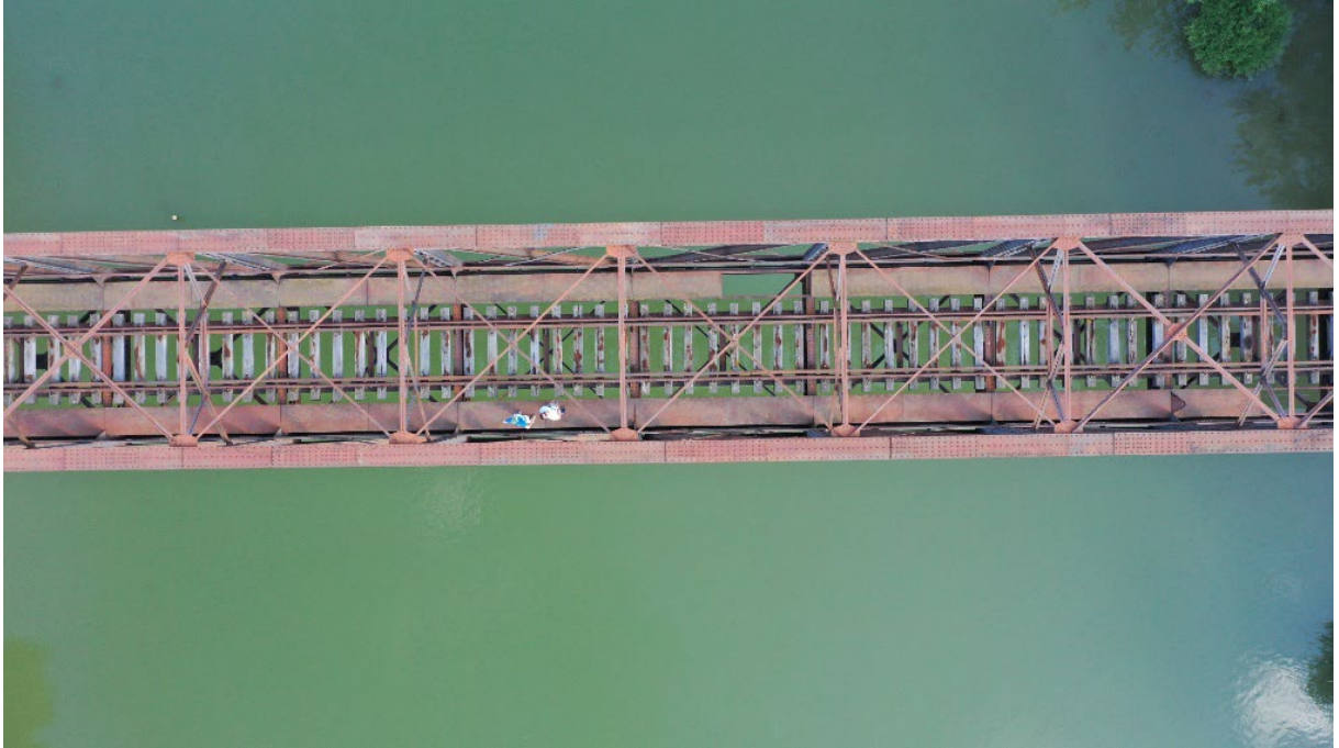
Vista cenital del puente de El Carrascal con las piezas de unión superior entre las dos vigas laterales a la vista.
