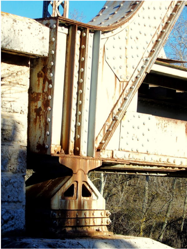
Detalle del estribo oeste, lado Valladolid, del Puente de El Empecinado y su peine de rodillos que permitir su desplazamiento.
