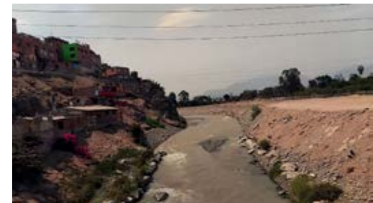
Fig. 49. Vista hacia el horizonte en dirección Noreste a partir del Puente Lurín.
