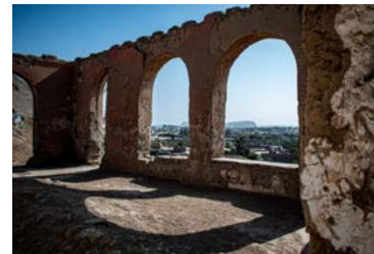
Fig. 43. Vista desde la Hacienda Buena Vista hacia su entorno territorial y natural.
