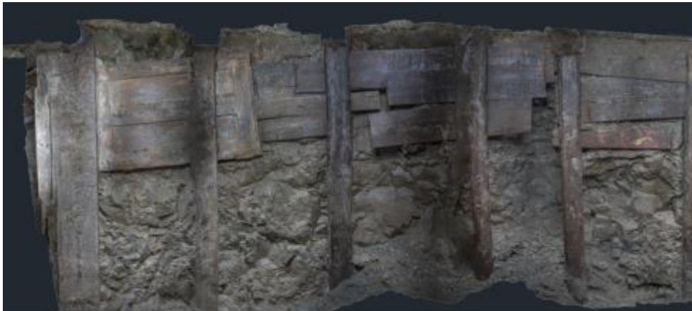
Figura 112. Ortoimagen de detalle del alzado Este de la Galería 2, con elementos de carpintería reutilizados como método de contención de las arcillas expansivas.
