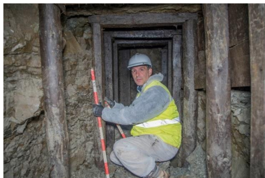
Figura 97. Trabajos con riesgo de derrumbe.
