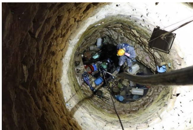
Figura 127. Trabajos previos, limpieza y acondicionamiento.
