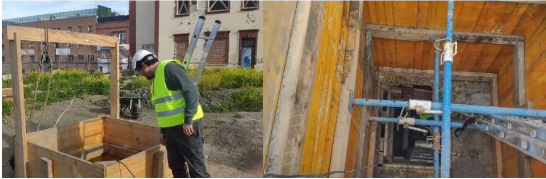
Figura 96. Inspección visual desde el pozo de acceso.
