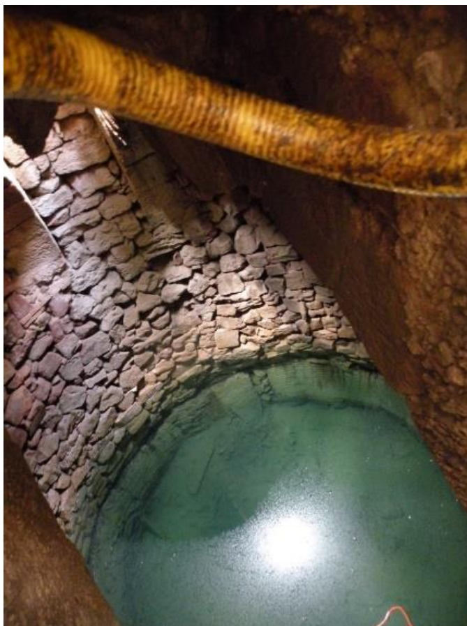
Figura 138. Estado anterior del interior de la noria.
