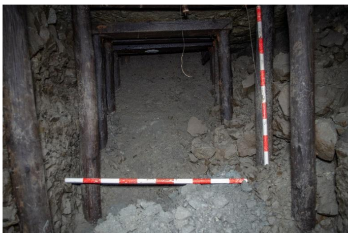
Figura 108. Vista de la Galería 1 desde acceso.
