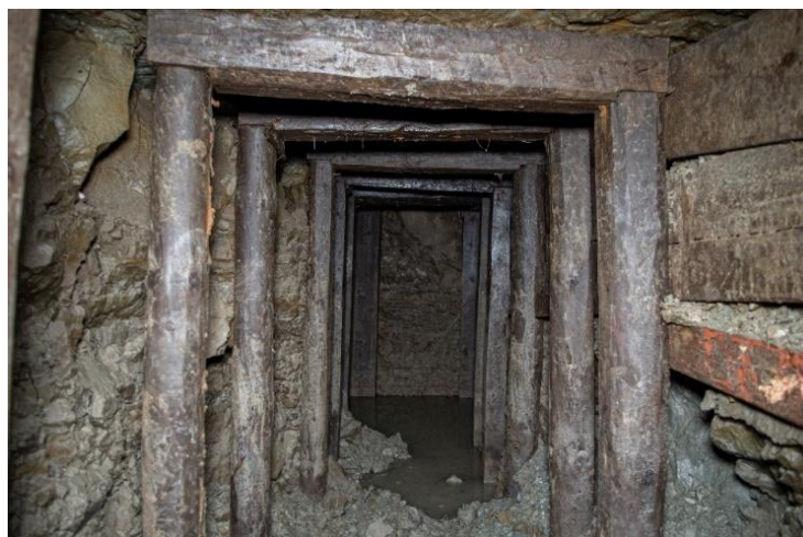
Figura 104. Vista del sistema de entibado en la Galería 2 (desde el punto de acceso).
