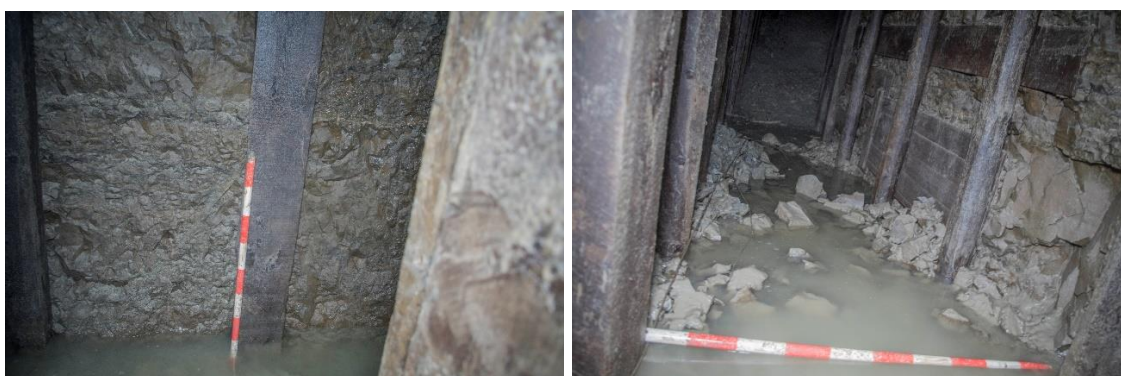
Figura 115. Galería 3 anegada con escala.
