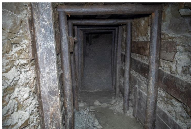
Figura 113. Vista Oeste de la Galería 3.
