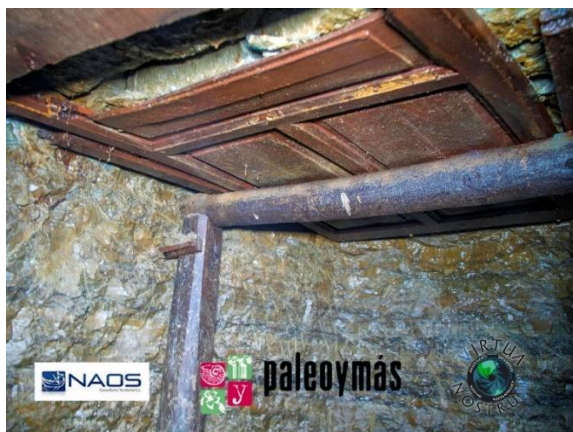
Figura 95. Puerta reutilizada como elemento de contención para evitar el derrumbe de la galería.
