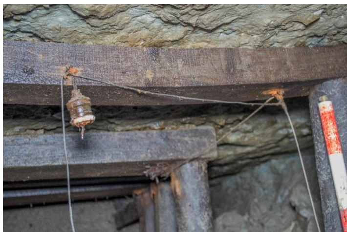
Figura 109. Bombín y cableado en la Galería 1.
