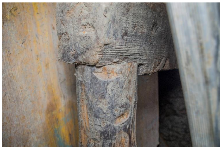
Figura 107. Detalle de unión de postes de entibado de las galerías.
