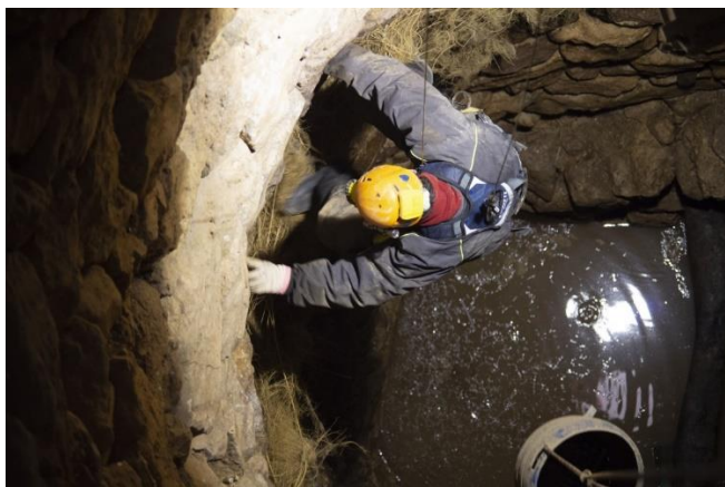
Figura 129. Limpieza de raíces y algas de las paredes del pozo.
