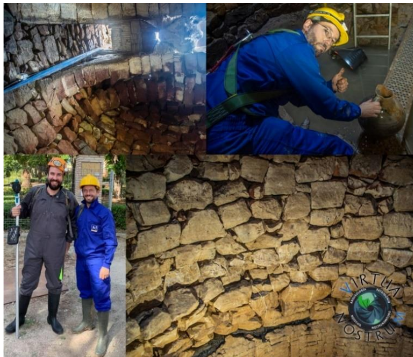
Figura 139. Infografía resumen de los trabajos realizados.
