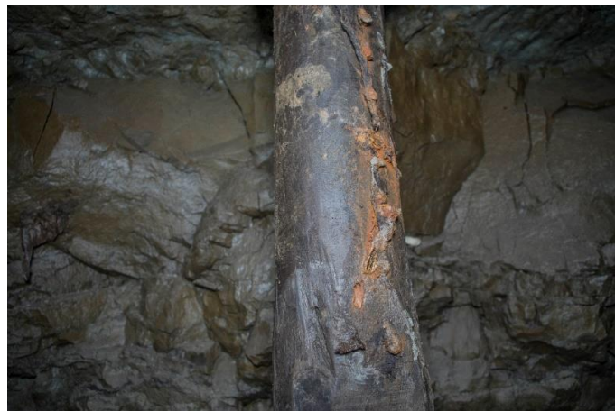
Figura 106. Detalle de poste con restos de cuerdas claveteados (Galería 2).
