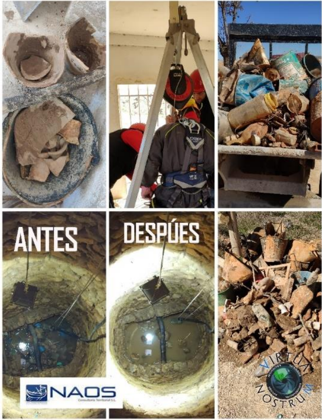
Figura 137. Infografía resumen de los trabajos realizados.
