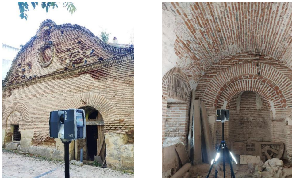
Figura 86. Proceso de toma de datos 3D láser exterior (izquierda) e interior (derecha).
