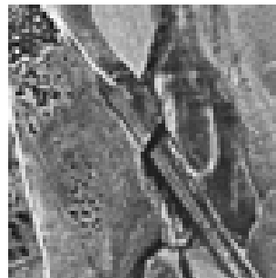
60 Puente de la Cañada
