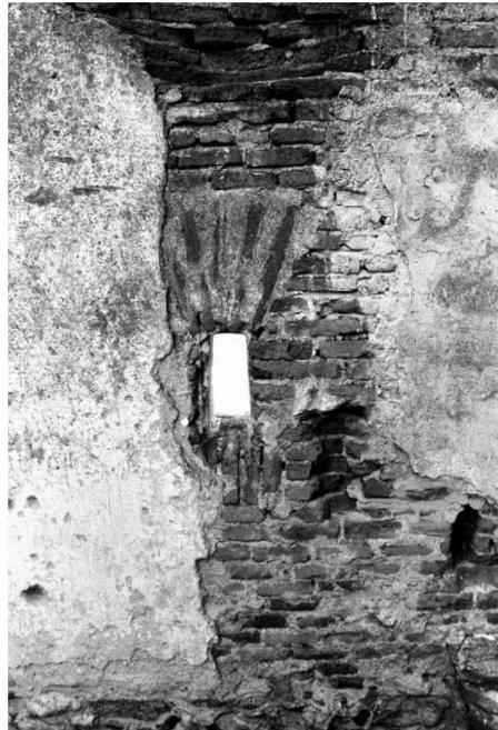
Figura 22. Interior de la torre de Codorniz (Segovia), con la impronta de la escalera de caracol en el ángulo (izquierda) y la aspillera para fusilería vista desde el interior (derecha). Fotografías del autor.
