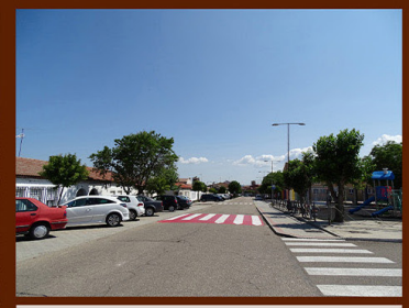
Calle Pío Basanta en las proximidades del colegio
