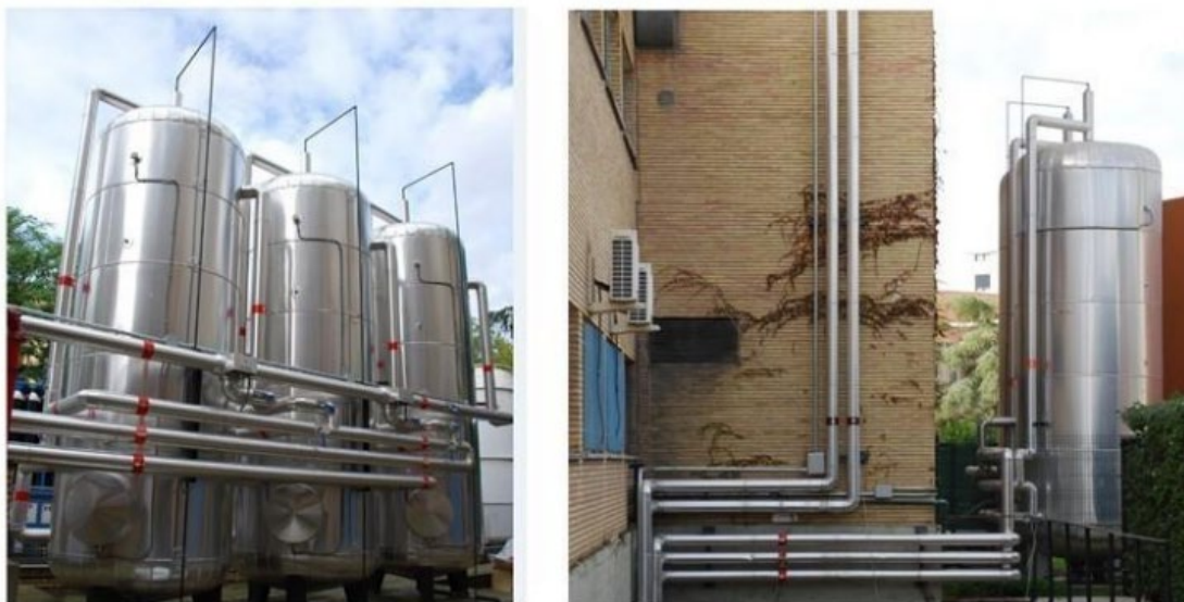
Figura 31: Montaje de acumuladores solares en el exterior y los circuitos hidráulicos que los conectan. [4]
