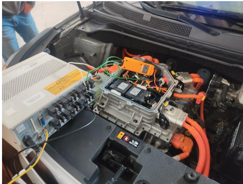
Figura 27. Medición de carga de vehículo eléctrico
