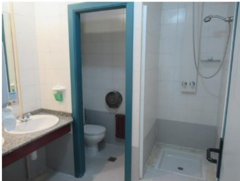
Img. 10: Baños de las habitaciones.
