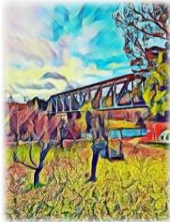
PUENTE DE HIERRO
