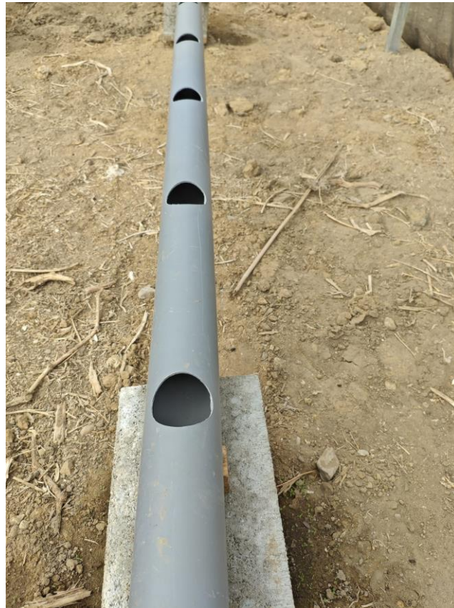
FIGURA 4.2. Tubos PVC utilizados en el sistema hidropónico. Fuente: elaboración propia.
