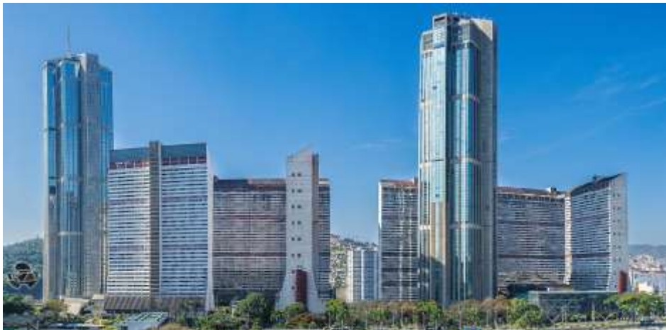
Fig. 28: Complejo Parque Central Recuperado de: https://n9.cl/hr7f3
