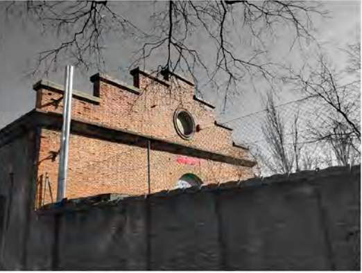
Los árboles salvajes se alzan en el interior, reforzando la imagen de una ruina viva.
