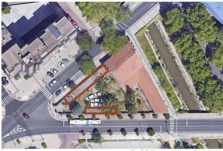
Fig. 8 Edificaciones existentes a demoler
