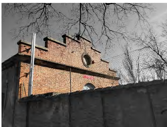
Fig. 3 Fotografía actual de la nave desde el Camino del Cementerio
