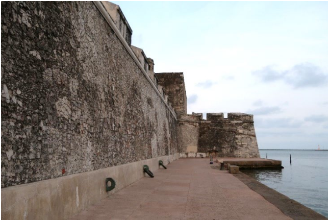
Muro de las argollas donde atracaban los navíos que llegaban a la Nueva España, San Juan de Ulúa, Veracruz.
