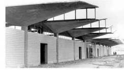
6. Nave de Talleres del Colegio de Cristo Rey. Fotografía de la marquesina durante la obra.
