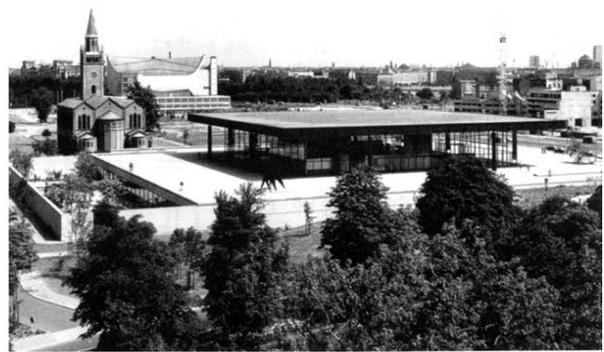
La estructura de la cubierta es de vigas bidireccionales, descansa sobre 8 soportes ordenados geoméricamente en la intersección de la cubierta con un cuadrado similar, girado 45°. Los muros de la sala, enteramente de vidrio de suelo a techo, permanecen invisibles tras el perímetro de la cubierta.
