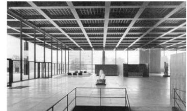
Como el *Templo de Segesta* sin cella, la *Galería Nacional* se define únicamente mediante el orden sin basa, sus columnas apoyan directamente sobre el estilóbato, encima descansan las jácenas exteriores y las transversales, haciendo las primeras de entablamento y las últimas señalándose como triglifos.
