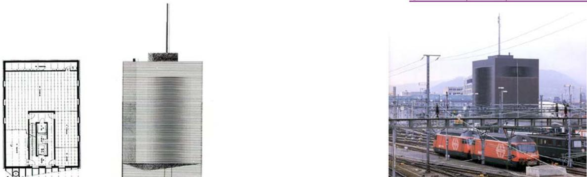
Su estrategia de imagen resultó de impregnarse con la condición metálica de lugar. A través de un recubrimiento de láminas de cobre de 20 cm de anchura, se "envolvió" todo el volumen, incluida la chimenea de ventilación. Chapa que se gira frente a las ventanas.
