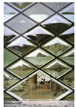
La estructura del perímetro es a base de una malla de perfiles de acero, con geometría de romboidal. Los huecos de estos rombos se cierran con cristal de diversas características, creando una diversidad perceptiva en las superficies del cerramiento: cristales cóncavos, convexos, planos, ahumados, fijos o practicables.
