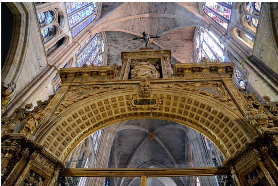
FIGURA 3. Arranque del arco en el nivel de encuentro entre las dos fases constructivas, trascoro de la catedral de León, León, ca. 1574-1575.
