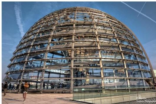
Las cúpulas pasan de tener **paralelos** comprimidos en la zona superior a tener paralelos traccionados en los paralelos de los riñones.
