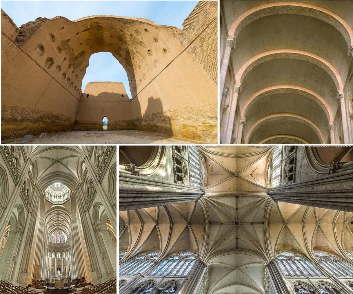
Las bóvedas son una buena respuesta técnica a la cubrición de espacios (bóvedas de iglesias y catedrales) y creación de superficies transitables (puentes). Las primeras únicamente tienen una función estética, y las segundas una función estructural. Las primeras bóvedas fueron una sucesión de arcos sin trabazón que evolucionaron a bóvedas con hiladas trabadas que permitían el comportamiento de estas asemejándolas a cascarones continuos.
