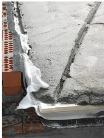
CUBIERTA CON CAPA DE MORTERO SOBRE EL AISLAMIENTO PREPARADA PARA RECIBIR EL SOLADO
