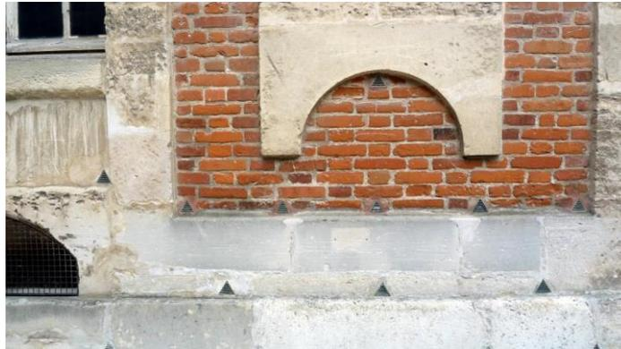
**Cámaras de ventilación:** Cámaras que, adosadas a los muros, por su cara exterior o por la interior, permiten la ventilación y secado de los muros.
