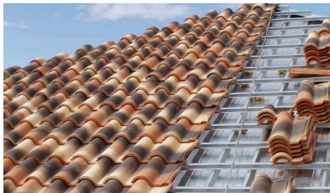
CUBIERTA VENTILADA AL DISPONER LAS TEJAS SOBRE UN SISTEMA DE RASTRES
