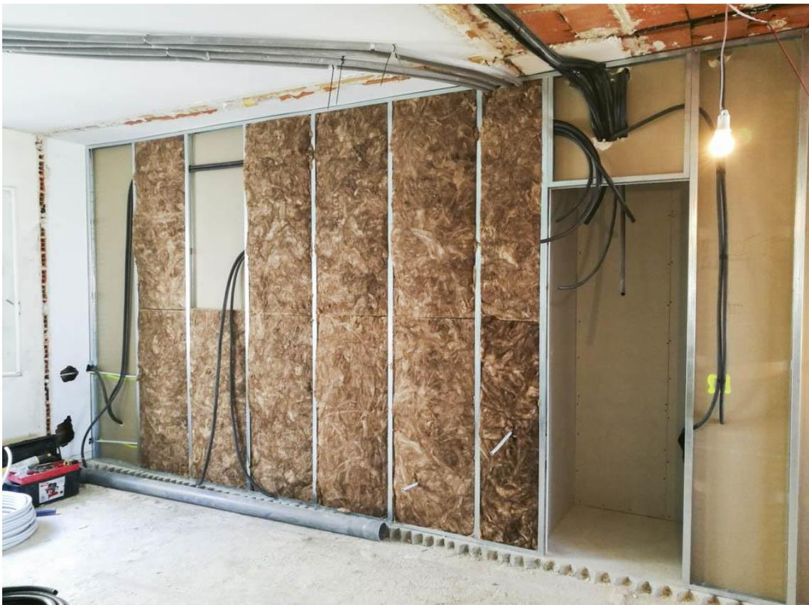
Al igual que ocurre en los tabiques de ladrillo, en este sistema hay cajas de registro, cajas de mecanismos, etc. que se fijan al paramento con anclajes específicos. Las paredes de PVL también pueden recibir todo tipo de revestimientos, y sujetar todo tipo de baldas y cargas que estén dentro de la capacidad portante del sistema. Este tipo de tabiquería se puede hacer también con un sistema similar, pero con materiales de madera, si bien su uso no es muy frecuente en nuestro entorno.
