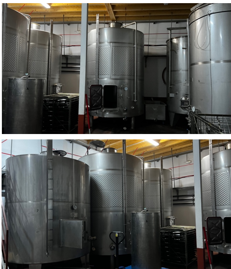
Figura 1.3 – Sala de fermentación de la bodega, equipada con depósitos de acero inoxidable que permiten un control preciso de la temperatura durante la elaboración.
