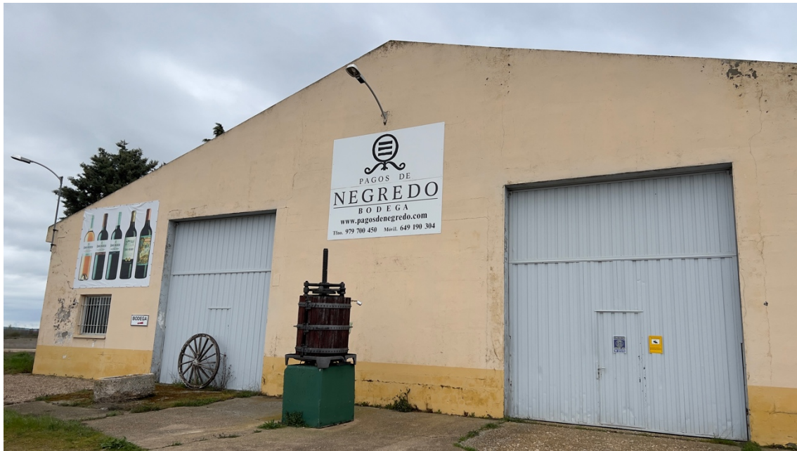
Figura 4.1 – Fachada principal de la bodega.
