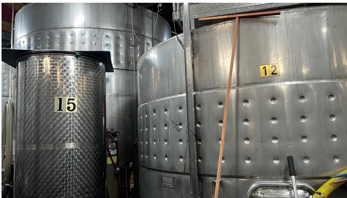
Figura 3.7 – Depósitos de acero inoxidable numerados, empleados en la fermentación y almacenamiento del vino.
