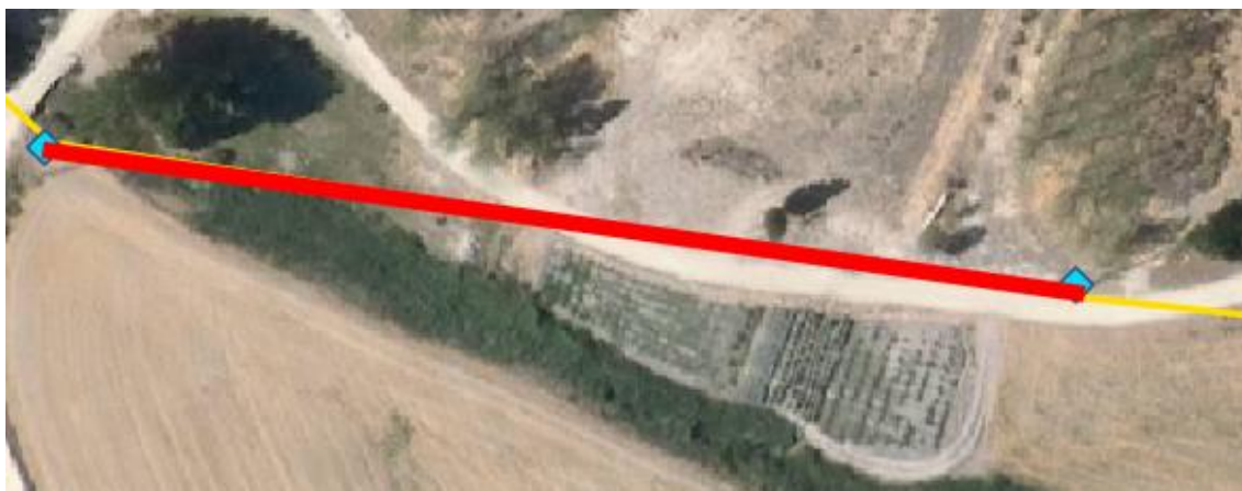
Imagen 43. Foto detalle obra 10.
