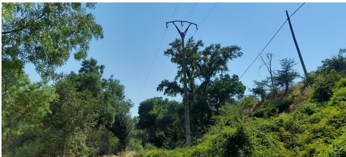
Imagen 6. Obra 2. Podas a trepa
