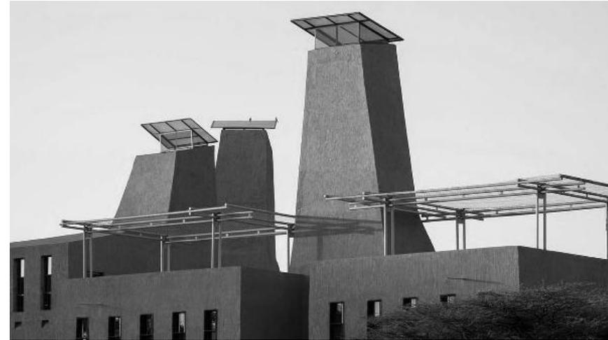
[Figura 35]. Fotografía del Startup Lions Campus por Kéré Architecture. Fotografía de Kinan Deeb. Ejemplo de ventilación por efecto chimenea.
