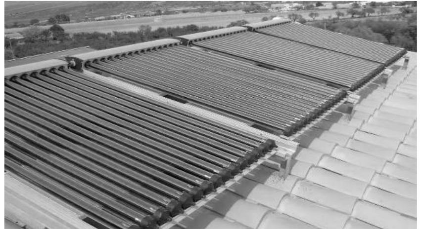
[Figura 52]. Tubos de vacío.
