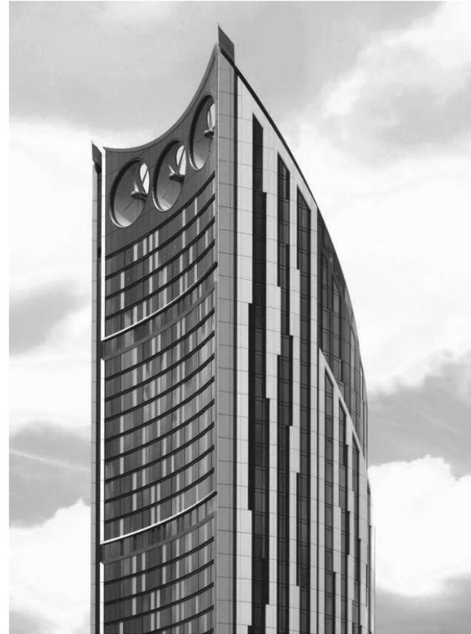
[Figura 62]. Fotografía del Strata SE1 de BFLS en Londres (2010). Fotografía hecha por Will Pryce. Ejemplo de energía minieólica.
